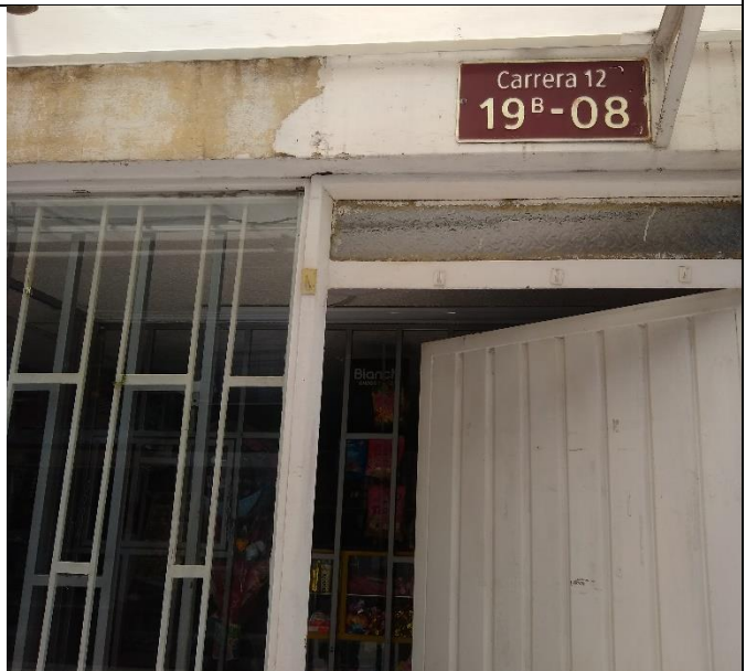
Foto No. 2 Detalle de la nomenclatura vista en la fachada del predio.
