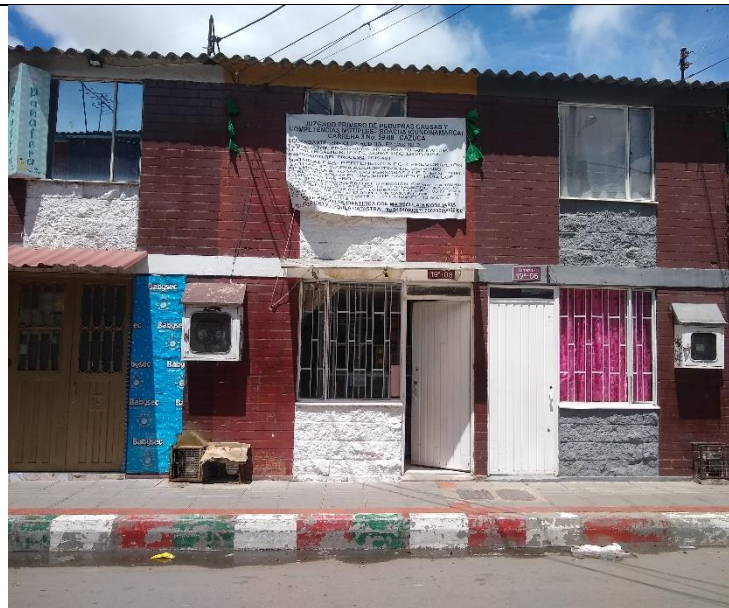
Foto No. 1 Predio objeto del proceso localizado en la Calle 15 No.7A-18 de Soacha, Cundinamarca.
