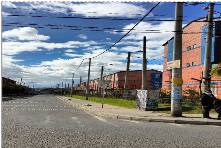
Vías de acceso
