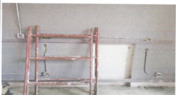
Imagen 13. Curvas de tubería eléctrica
