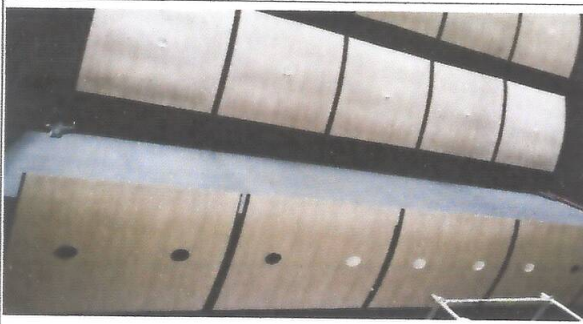
Imagen 17. Muro dintel proscenio
