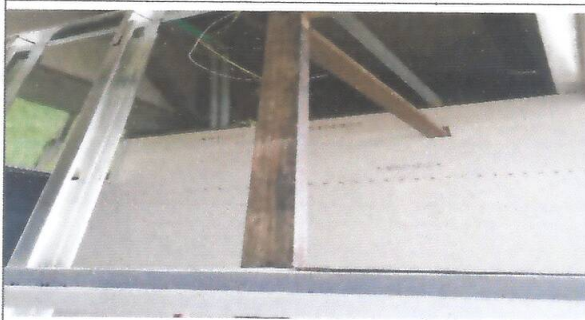
Imagen 41. Elementos metálicos de soporte
