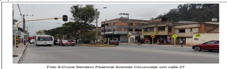
Foto 9-Cruce Sendero Peonatal Avenida Circunvalar con calle 27
