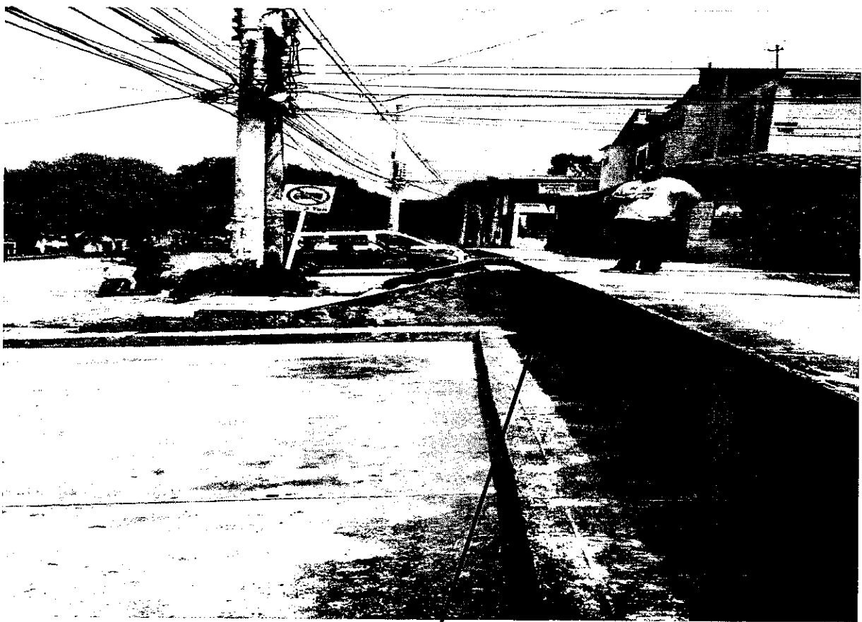
Se puede observar la falta de barandas de seguridad cerca a la calle 5E No 16-03 y 16-04 en el barrio san marcos del municipio de Piedecuesta donde está el andén y la bahía
