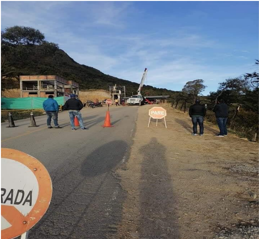
Fotografía del Montaje de la Caseta
