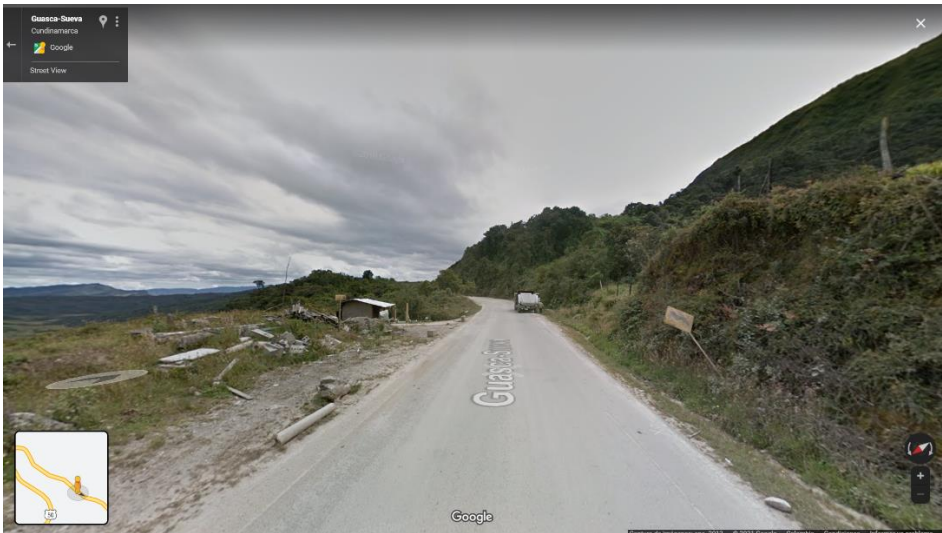
Fotografía del Páramo antes de Construir el Peaje
