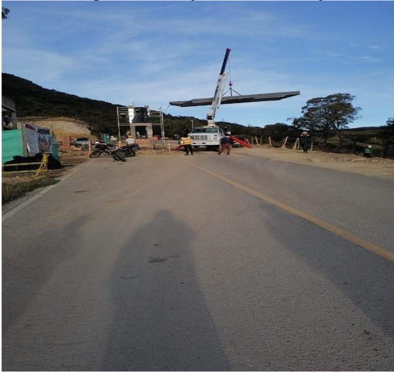
Fotografía del Montaje de la Caseta
