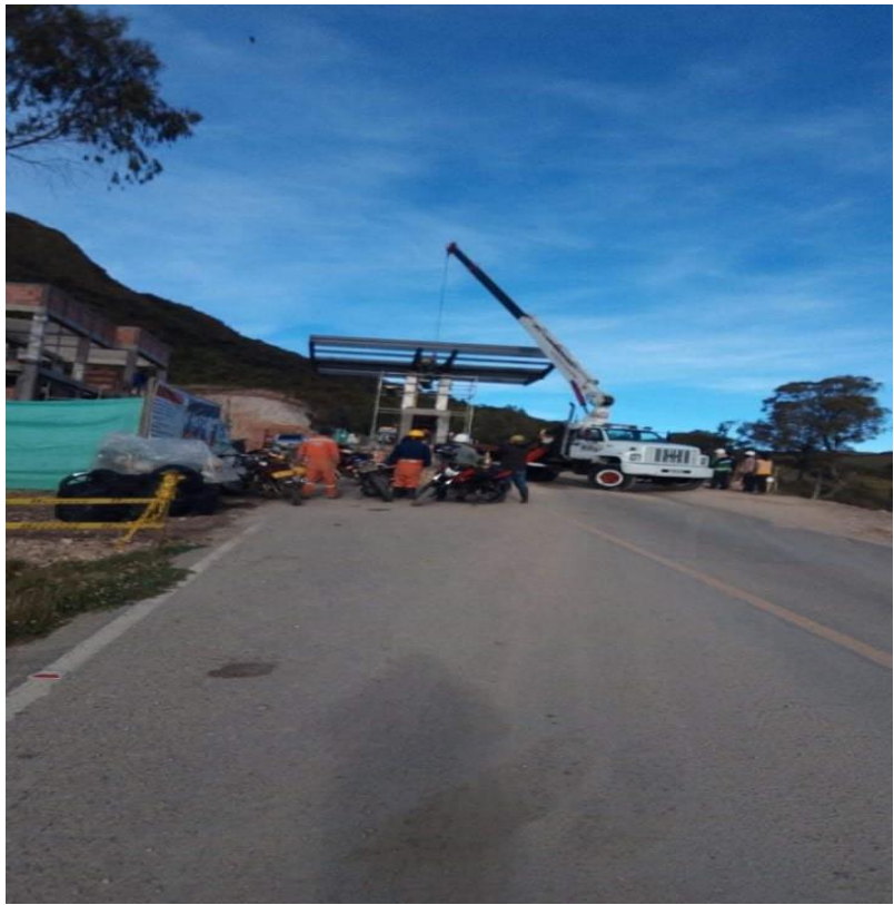
Fotografía de Montaje de Caseta Amoladero Fotografía del Montaje de la Caseta o Peaje
