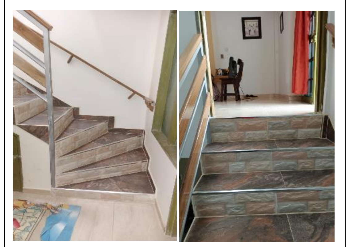
ESCALERAS ACCESO 2 PISO
