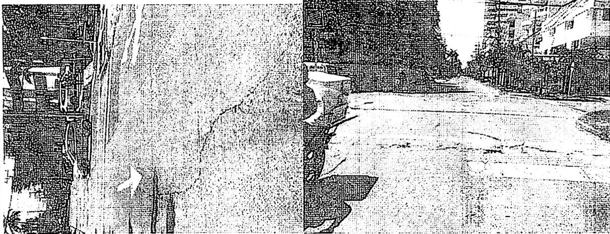
A continuación, el juez expresó los resultados de lo percibido por él, así: "Se hizo un recorrido por toda la avenida Piñango, Calle 5A del Barrio Castillogrande y se observó un notable deterioro a lo largo de toda esta vía, fisuras en el pavimento, baches en algunas secciones de las losas del pavimento de principio a fin tal como registra el material fotográfico inserto. De igual manera se percató el Despacho que se trata de una vía con alta densidad vehicular".
