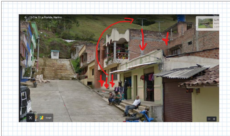
Figura 17 análisis de cargas gravitacionales de la edificación del señor Jesús Hidalgo (demandante) con tendencia de asentamientos hacia la parte posterior.
