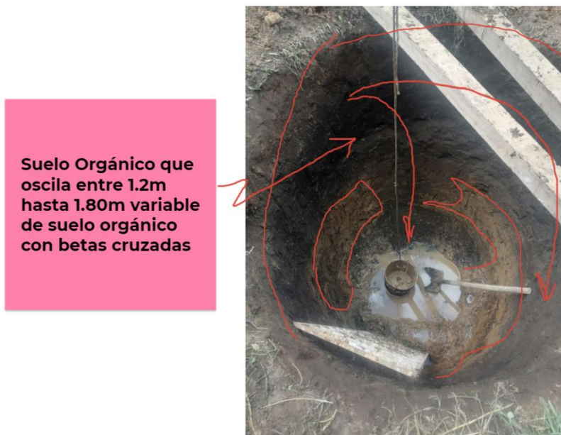
Figura 51 Suelo orgánico que oscila entre 1.2m hasta 1.80m variable de suelo orgánico con betas cruzadas.
