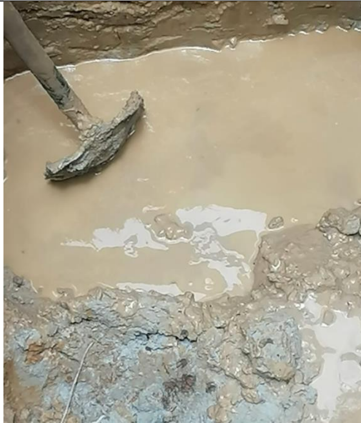
Figura 53 Suelo altamente compresible, suelo cohesivo.
