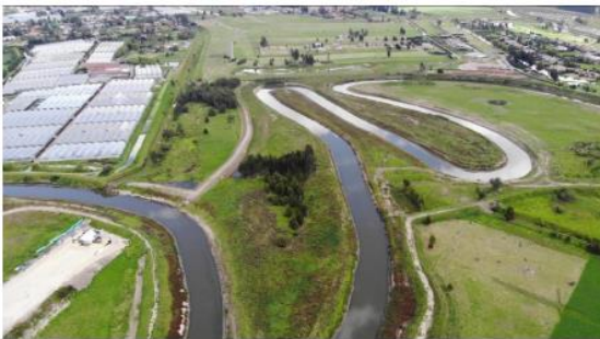
Figura 2. Humedal (H1) de San Jacinto en donde se observan el dique que lo dividió, los remanentes H1a y H1b, la construcción de la carretera justo enfrente del H1a, que desaparecería con la continuación de la misma.
