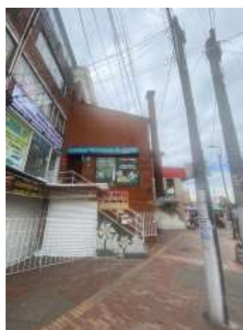
Imagen 2. Visita general del Sector – Ubicación del Local Comercial
