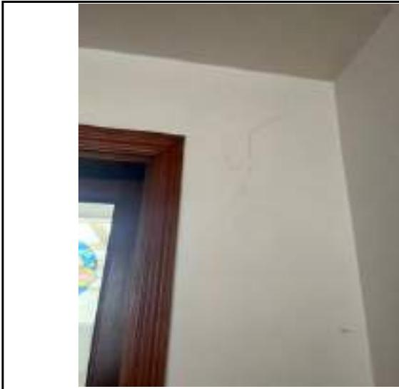
DESCRIPCIÓN: Vista en detalle fisura diagonal en parte alta de muro esquina sur oriental de habitación 2.
