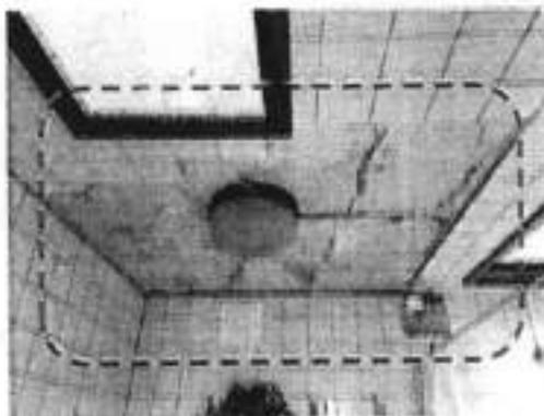
Fotografía 36. Caída de baldosas de placa de cubierta zona de baño del apartamento 301 predio P1.
