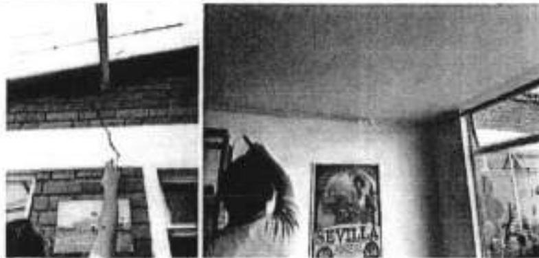
Fotografías 23 y 24. Grietas y fisuras en muros interiores y en vértices entre placa de entrepiso y muros interiores del apartamento 101 predio P1.
