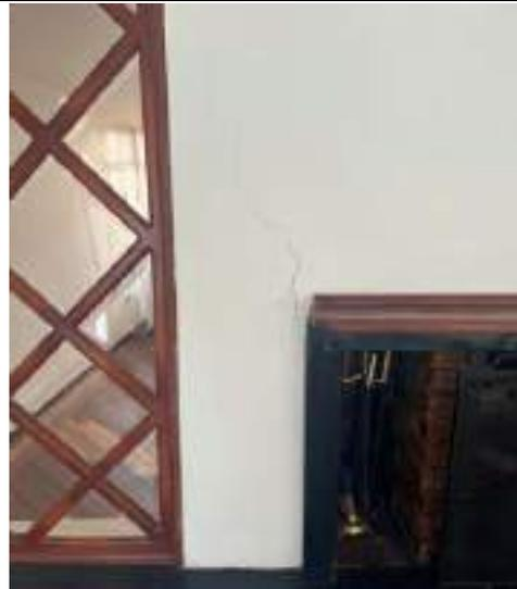
DESCRIPCIÓN: Vista en detalle fisuras en zona media de muro de chimenea en costado occidental de apartamento 101.
