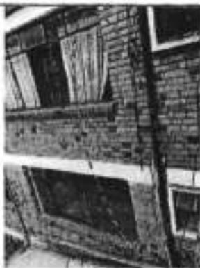
Fotografía 2. Grieta en muros perimetrales costado occidental predio P1.
