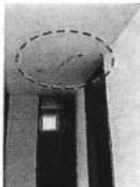
Fotografía 29. Fisuras y grietas en recubrimiento cara interna de placa de entrepiso del apartamento 201 predio P1.
