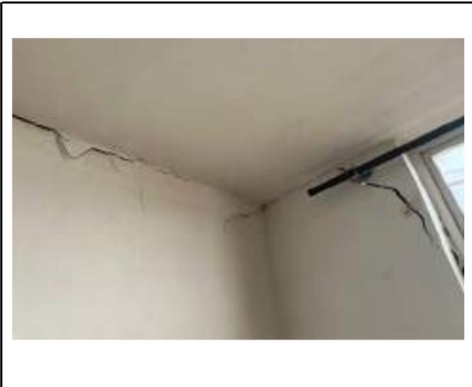
DESCRIPCIÓN: Vista en detalle fisura horizontal en cielorraso y parte alta de muro sur de habitación 2, apartamento 101.
