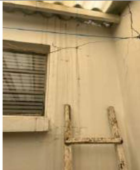
DESCRIPCIÓN: Vista en detalle manchas por humedad de filtración en parte alta y media de muro occidental de patio interior oriental, apartamento 101.
