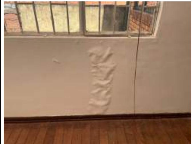
DESCRIPCIÓN: Vista en detalle fisuras, embombamientos y humedad por filtración en antepecho, zona central muro costado norte de patio interior occidental.
