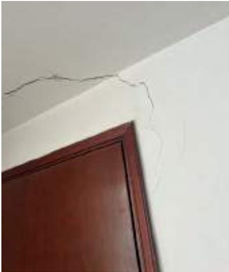
DESCRIPCIÓN: Vista en detalle grietas y fisuras en parte alta de muro y cielorraso en esquina sur occidental de habitación 1.
