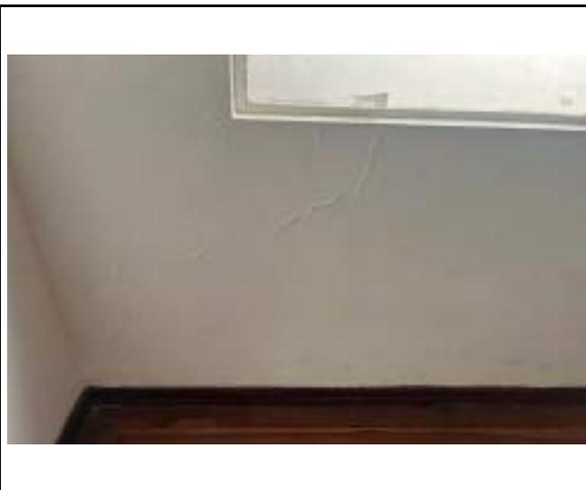
DESCRIPCIÓN: Vista en primer plano fisura diagonal en parte baja de muro costado occidental de habitación 2.
