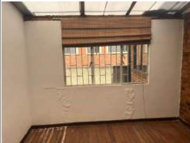
DESCRIPCIÓN: Vista en primer plano fisuras, embombamientos y humedad por filtración en muros y antepecho muro costado norte de patio interior occidental.
