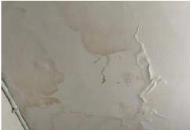
DESCRIPCIÓN: Vista en detalle fisuras en cielorraso, manchas, humedad por filtración y embombamiento en costado noroccidental de zona de ropas.
