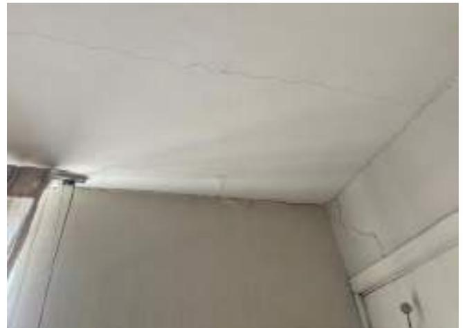
DESCRIPCIÓN: Vista en detalle grieta y fisuras diagonales en parte alta de muro y cielorraso, esquina sur occidental de habitación 1.
