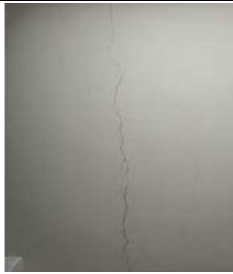
DESCRIPCIÓN: Vista en detalle grietas y fisuras en cielorraso en baño principal.
