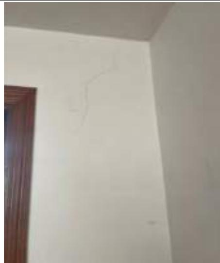
DESCRIPCIÓN: Vista en detalle fisura diagonal en parte alta de muro esquina sur oriental de habitación 2.
