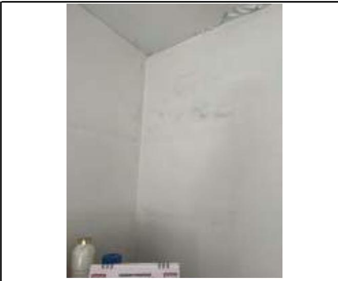
DESCRIPCIÓN: Vista en detalle fisura horizontal y vertical en parte media de muro costado occidental de habitación 1.
