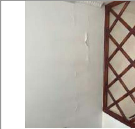
DESCRIPCIÓN: Vista en detalle fisuras y embombamientos en en zona media y alta de muro sala en costado occidental de apartamento 101.
