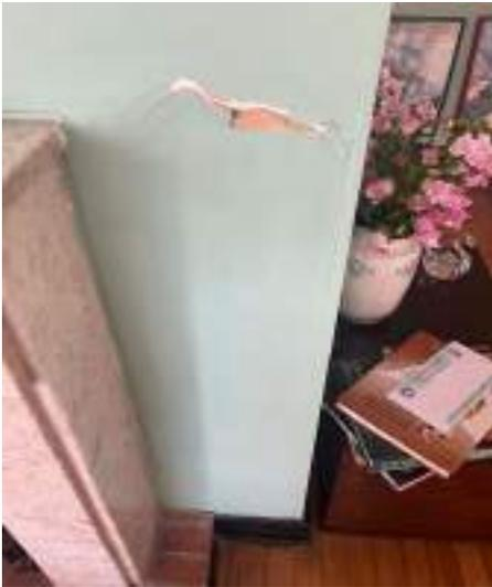
DESCRIPCIÓN: Vista en detalle fisuras y desprendimientos en zona media de muro de chimenea, cara sur.
