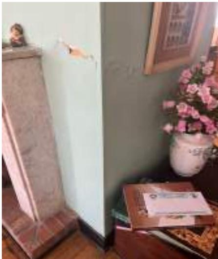
DESCRIPCIÓN: Vista en detalle fisuras y desprendimientos en zona media de muro de chimenea, cara sur y oriental.
