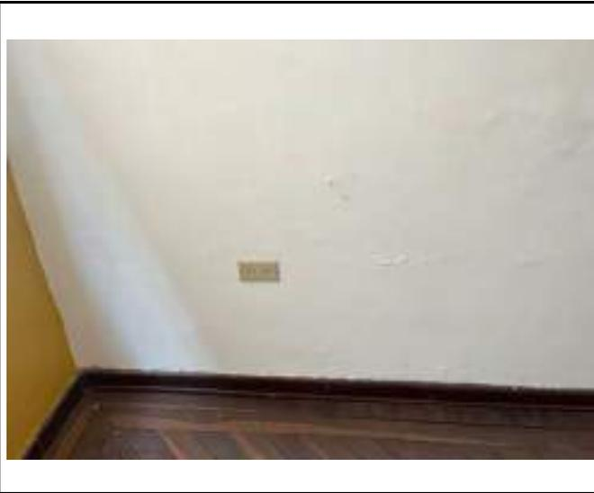
DESCRIPCIÓN: Vista en detalle fisura horizontal en parte baja y media de muro, habitación 3.
