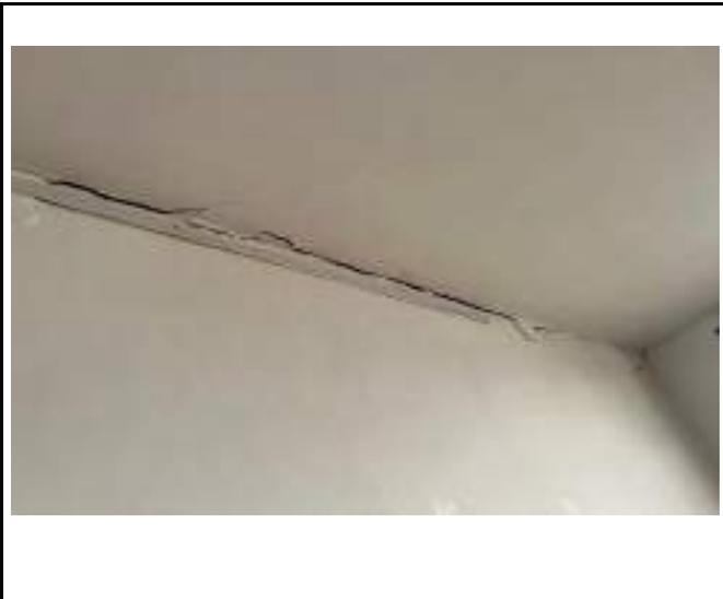
DESCRIPCIÓN: Vista en detalle fisura horizontal en zona entre muro y cielorraso en muro sur de habitación 2, apartamento 101.
