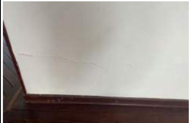
DESCRIPCIÓN: Vista en detalle fisuras y embombamientos en parte baja de muro de chimenea costado norte zona de estudio.
