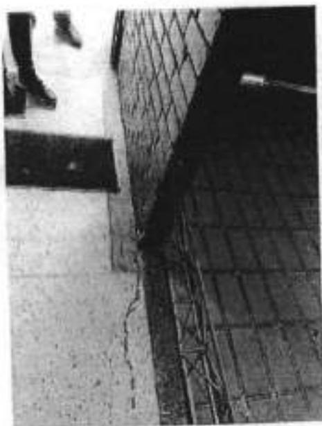
Fotografía 4. Fisuras en acabados de piso primer nivel predio P1.
