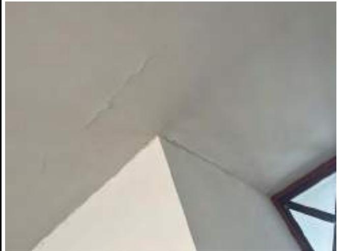
DESCRIPCIÓN: Vista en detalle fisuras en cielorraso costado noroccidental de chimenea.
