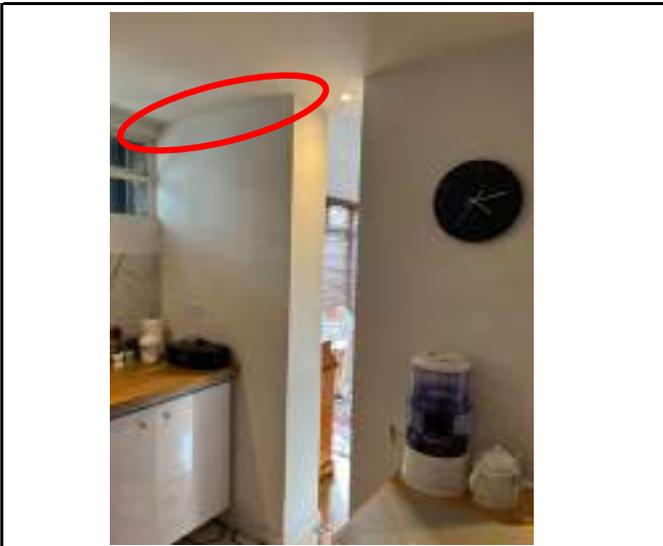
DESCRIPCIÓN: Vista en primer plano fisura horizontal en parte alta de muro en costado sur muro occidental de cocina.
