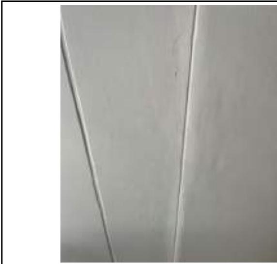
DESCRIPCIÓN: Vista en detalle fisuras longitudinales en cielorraso en zona de unión con viga.
