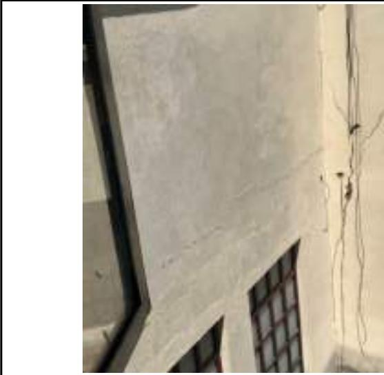
DESCRIPCIÓN: Vista en detalle grieta horizontal en costado occidental de vacío interior oriental.
