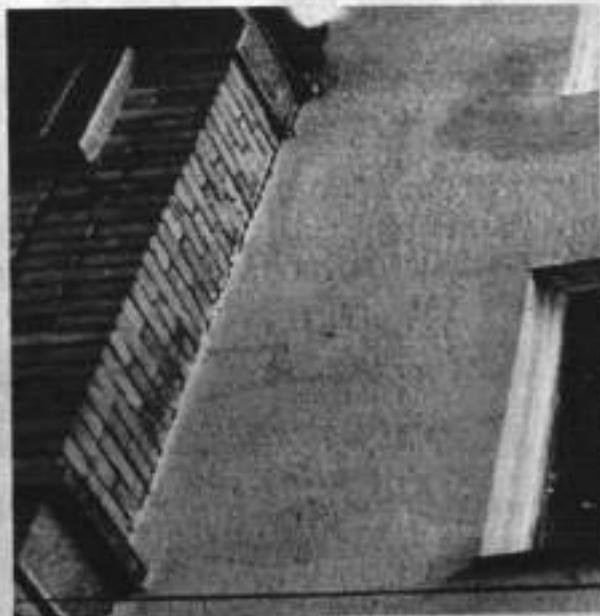
**FIG. 5 FISURA DE DESPRENDIMIENTO
