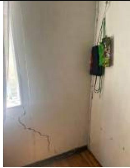
DESCRIPCIÓN: Vista en detalle grieta y fisuras diagonales en parte alta de muro y cielorraso, esquina sur occidental de habitación 1.
