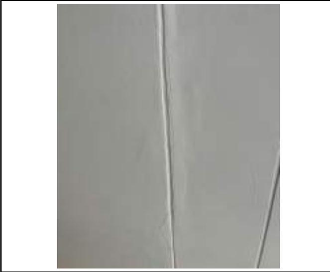
DESCRIPCIÓN: Vista en detalle fisuras longitudinales en cielorraso en zona de unión con viga.
