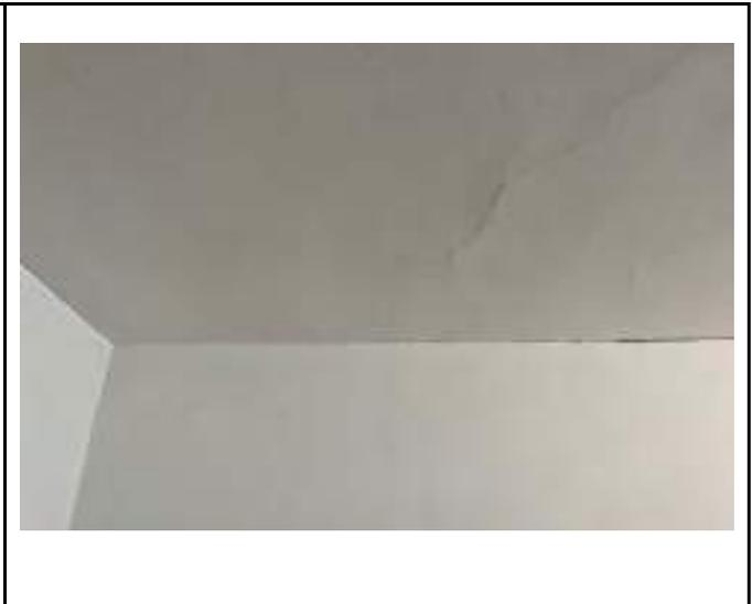
DESCRIPCIÓN: Vista en detalle fisuras en cielorraso en costado sur oriental de muros en habitación 2.
