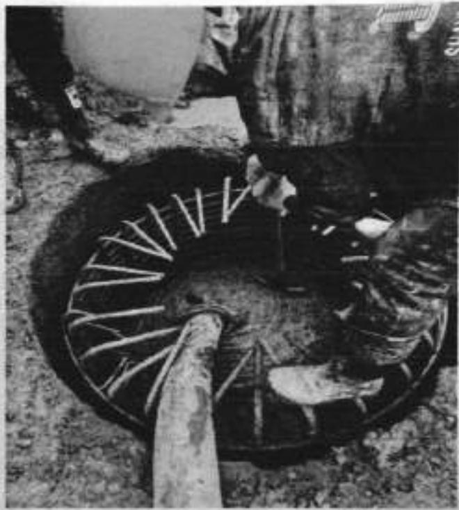
**FIG. FUNDICION CAISSON**
