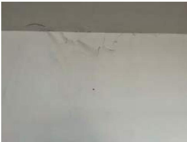
DESCRIPCIÓN: Vista en detalle fisuras y embombamientos en parte alta de muro de chimenea y cielorraso, costado norte zona de estudio.
