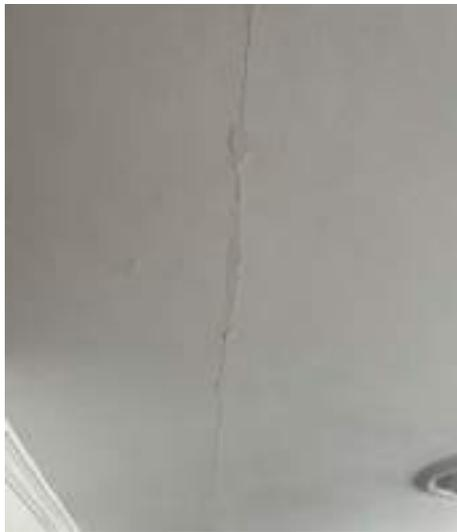
DESCRIPCIÓN: Vista en primer plano fisura longitudinal (sentido oriente - occidente) en cielorraso zona central de sala hacia costado occidental.
