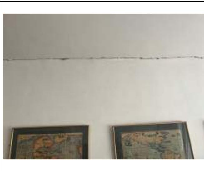
DESCRIPCIÓN: Vista en detalle fisura horizontal en zona de unión entre muro y cielorraso en costado oriental de habitación 1.
