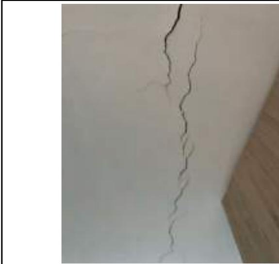
DESCRIPCIÓN: Vista en detalle grietas y fisuras en cielorraso en baño principal.
