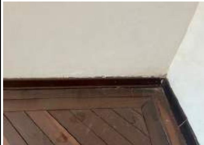
DESCRIPCIÓN: Vista en detalle fisura horizontal en parte baja de muro, habitación 3.
