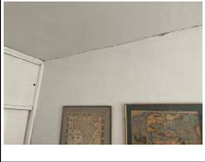
DESCRIPCIÓN: Vista en detalle fisura horizontal en zona de unión entre muro y cielorraso en costado oriental de habitación 1.
