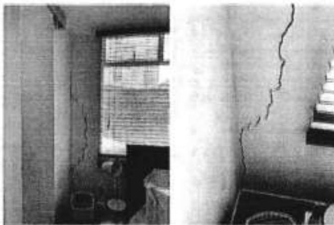
Fotografías 15 y 16. Fisura y grieta típica en muro perimetral (costado occidental) del apartamento 201 predio P1.
