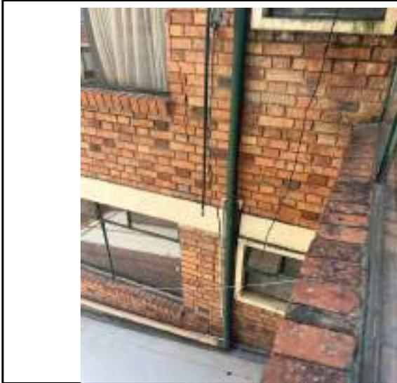
DESCRIPCIÓN: Vista en primer plano grieta vertical y diagonal y humedad por filtración muro de fachada interior occidental.
