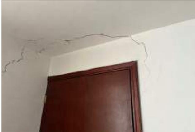
DESCRIPCIÓN: Vista en detalle grietas y fisuras en parte alta de muros y cielorraso en esquina sur occidental de habitación 1.
