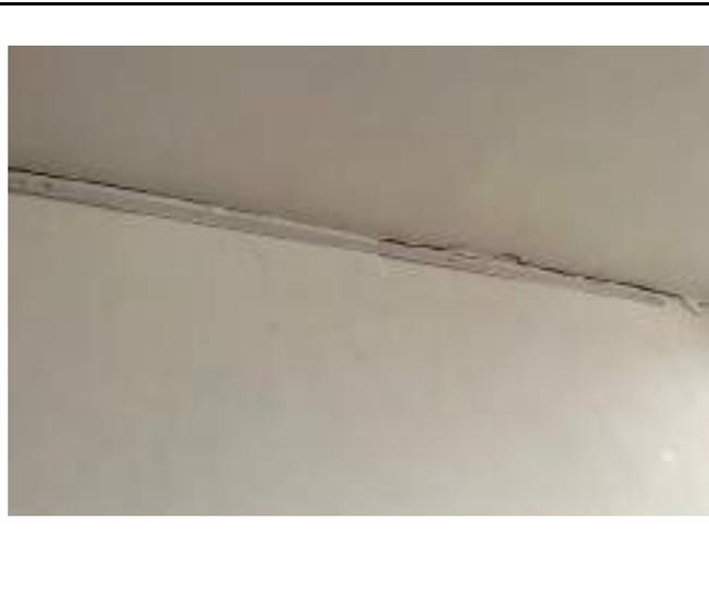
DESCRIPCIÓN: Vista en detalle fisura horizontal en zona entre muro y cielorraso en muro sur de habitación 2, apartamento 101.
