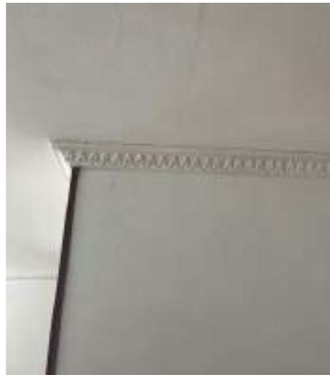
DESCRIPCIÓN: Vista en detalle fisuras en parte superior de muro chimenea en costado de occidental.
