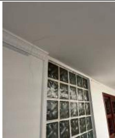
DESCRIPCIÓN: Vista en detalle fisura en parte alta de muro y cielorraso en muro occidental de corredor central.
