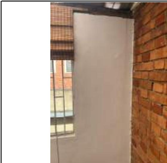
DESCRIPCIÓN: Vista en detalle manchas de humedad por filtración en parte alta de muro costado norte de patio interior occidental.
