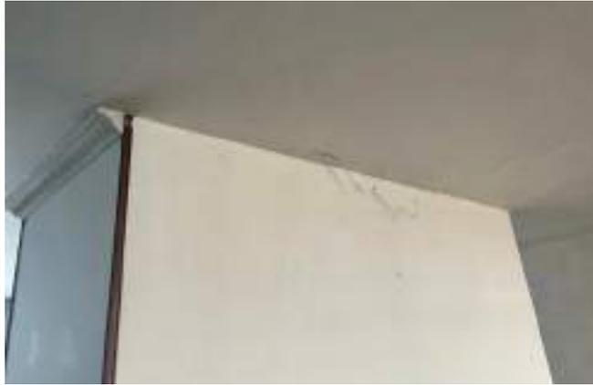
DESCRIPCIÓN: Vista en primer plano fisuras y embombamientos en parte alta de muro de chimenea y cielorraso, costado norte zona de estudio.
