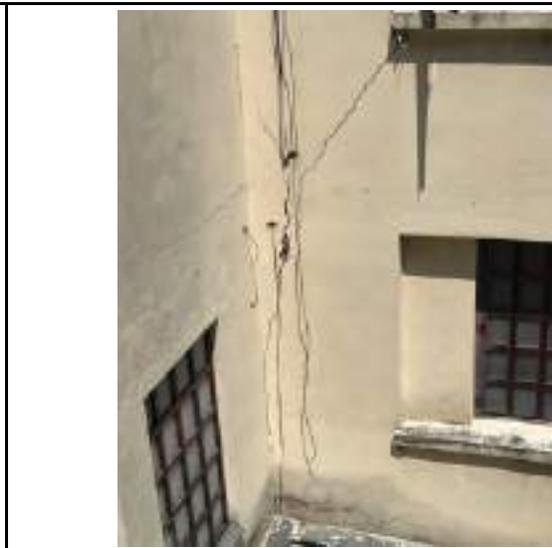
DESCRIPCIÓN: Vista en detalle grieta diagonal en costado norte de vacío interior oriental.
