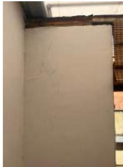
DESCRIPCIÓN: Vista en detalle fisuras en parte alta de muro costado norte de patio interior occidental.
