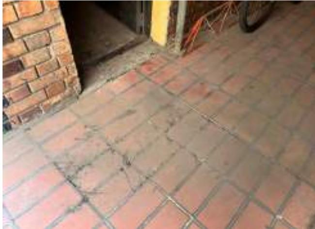
DESCRIPCIÓN: Vista en detalle fisuras, desportillamientos y suciedad en acabado de piso en zona de acceso a depósito.
