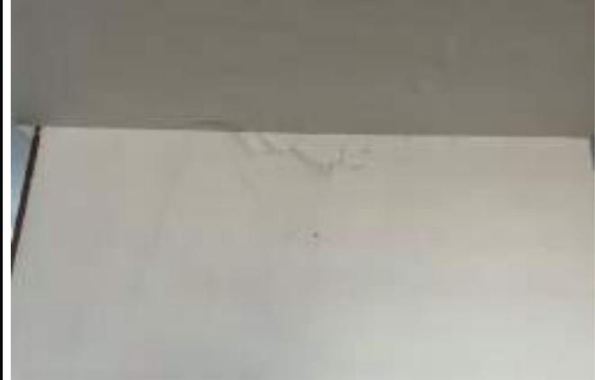
DESCRIPCIÓN: Vista en detalle fisuras y embombamientos en parte alta de muro de chimenea y cielorraso, costado norte zona de estudio.
