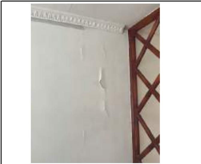
DESCRIPCIÓN: Vista en detalle fisuras verticales y embombamiento de pintura en muro costado occidental zona muro de chimenea y sala, colindante con edificio nuevo.
