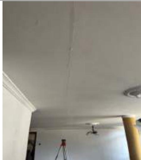
DESCRIPCIÓN: Vista en primer plano fisura longitudinal (sentido oriente - occidente) en cielorraso zona central de sala hacia costado occidental.
