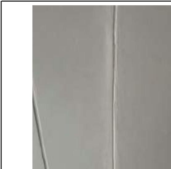
DESCRIPCIÓN: Vista en detalle fisuras longitudinales en cielorraso en zona de unión con viga.
