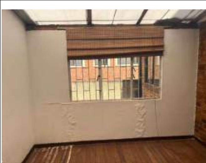
DESCRIPCIÓN: Vista en primer plano fisuras, embombamientos y humedad por filtración en muros y antepecho muro costado norte de patio interior occidental.
