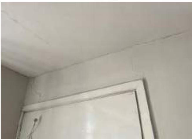
DESCRIPCIÓN: Vista en detalle grieta y fisuras diagonales en parte alta de muro y cielorraso, esquina sur occidental de habitación 1.
