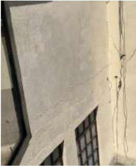
DESCRIPCIÓN: Vista en detalle grieta horizontal en costado occidental de vacío interior oriental.
