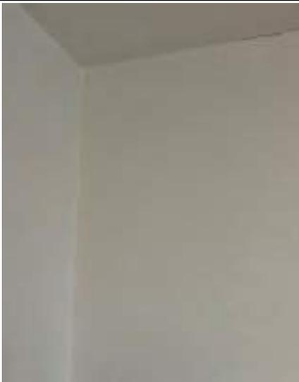
DESCRIPCIÓN: Vista en detalle fisuras horizontales en zona de unión entre muro y cielorraso en muro costado sur de habitación 1.
