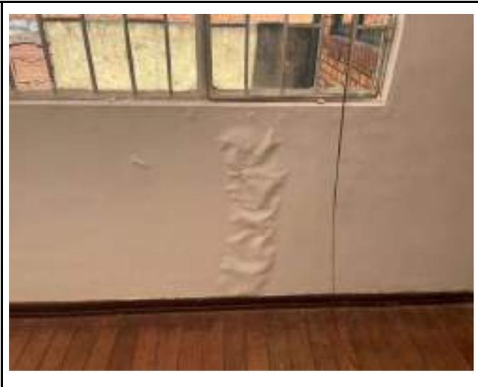
DESCRIPCIÓN: Vista en detalle fisuras, embombamientos y humedad por filtración en antepecho, zona central muro costado norte de patio interior occidental.
