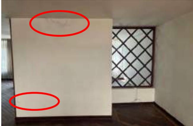
DESCRIPCIÓN: Vista en primer plano fisuras y embombamientos en parte alta y baja de muro de chimenea y cielorraso, costado norte zona de estudio.
