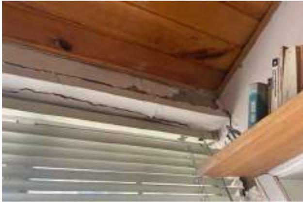
DESCRIPCIÓN: Vista en detalle fisuras horizontales, humedad y desprendimientos en parte alta de muro costado norte de estudio.
