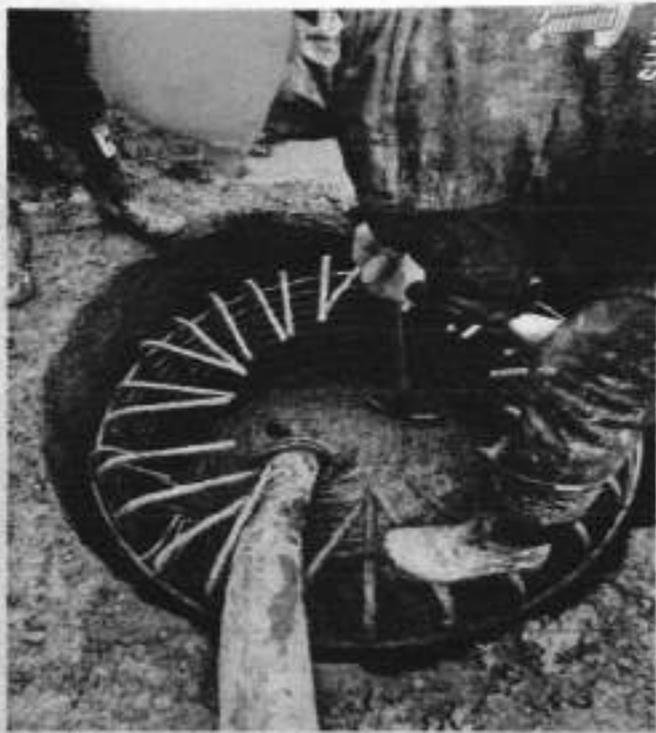
**FIG. FUNDICION CAISSON**
