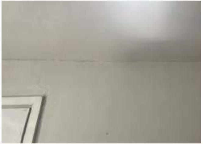
DESCRIPCIÓN: Vista en detalle fisura en parte alta de muro y zona de unión con cielorraso en costado sur occidental de habitación 1.
