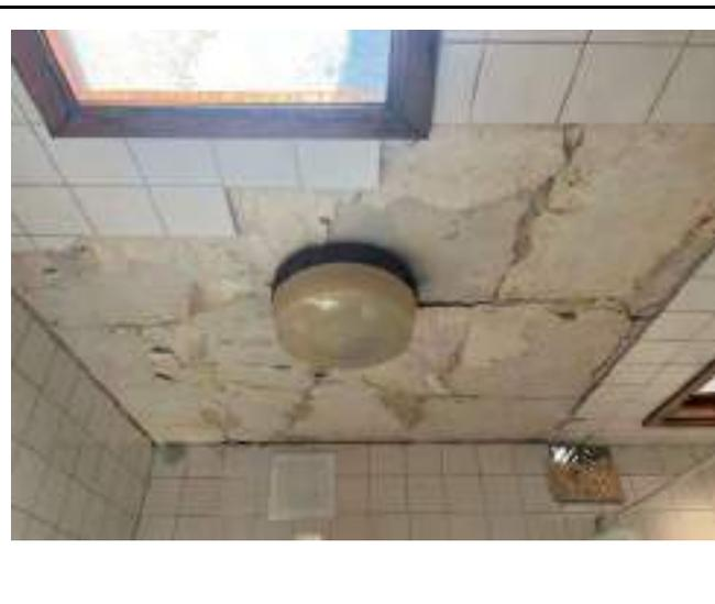
DESCRIPCIÓN: Vista en detalle fisuras, grietas, desprendimientos y humedad por filtración en cielorraso de baño principal.
