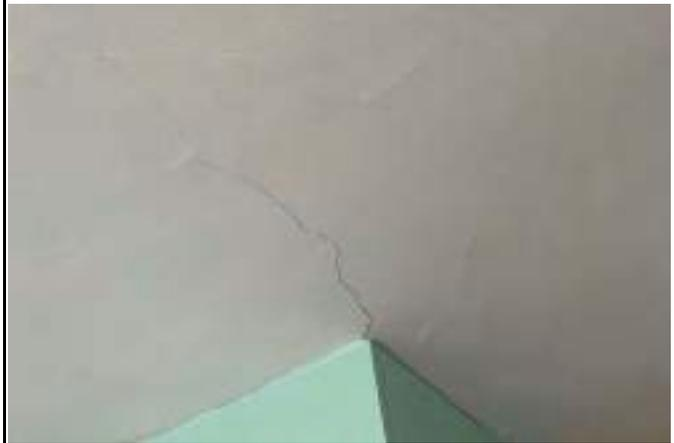
DESCRIPCIÓN: Vista en detalle fisuras en cielorraso en costado oriental zona de muro de chimenea.
