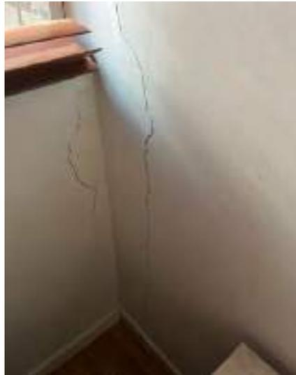
DESCRIPCIÓN: Vista en primer plano fisuras y grietas verticales en muros esquina costado nor oriental en zona de estudio.
