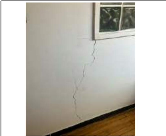
DESCRIPCIÓN: Vista en detalle fisuras verticales en parte baja y media de muro costado occidental de corredor de habitaciones.
