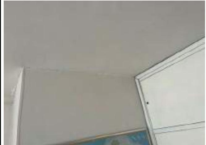
DESCRIPCIÓN: Vista en detalle fisura horizontal en zona de unión entre cielorraso y muro costado noroccidental de habitación 1.
