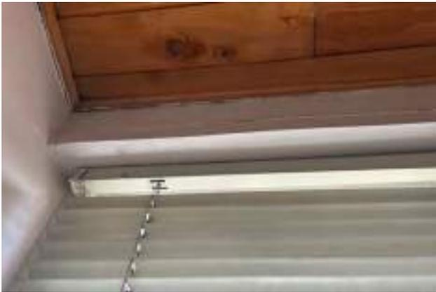
DESCRIPCIÓN: Vista en detalle fisuras horizontales en parte alta de muro costado norte de estudio.
