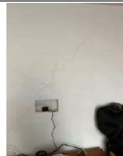
DESCRIPCIÓN: Vista en detalle fisuras diagonales y verticales en zona media cara norte de muro de chimenea.
