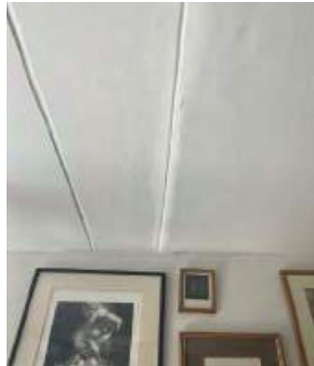
DESCRIPCIÓN: Vista en detalle fisuras horizontales en parte alta de muro costado occidental zona de sala.
