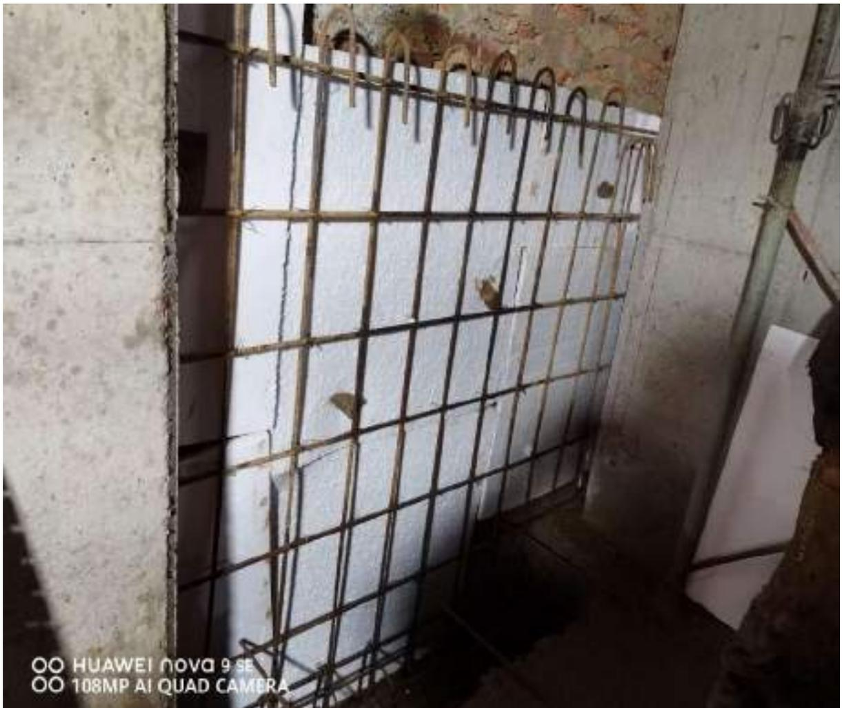
**FIG. 16 REFUERZO Y DILATACION CON ICOPOR PARA MURO DE CONTENCIÓN.**
