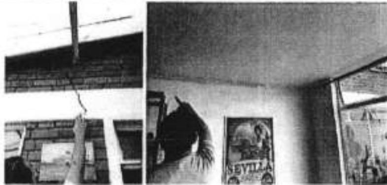
Fotografías 23 y 24. Grietas y fisuras en muros interiores y en vértices entre placa de entepiso y muros interiores del apartamento 101 predio P1.
