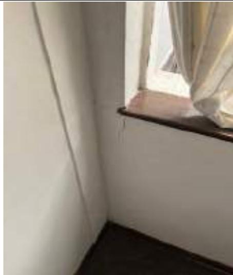
DESCRIPCIÓN: Vista en detalle grietas y fisuras verticales en parte baja de muro en esquina nororiental de habitación 1.
