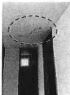
Fotografía 29. Fisuras y grietas en recubrimiento cara interna de placa de entrapiso del apartamento 201 predio P1.
