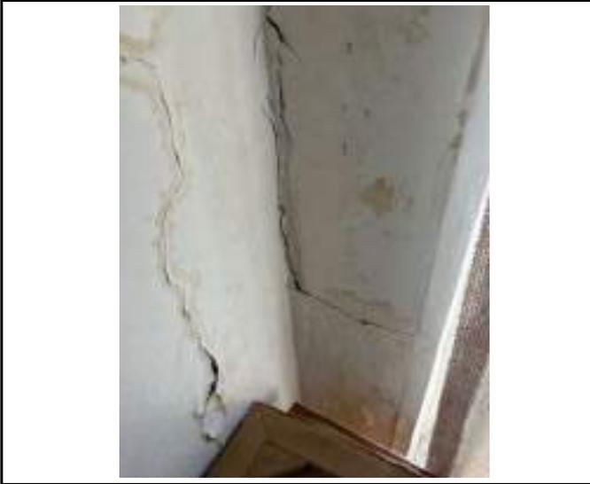
DESCRIPCIÓN: Vista en detalle grieta y fisuras diagonales y verticales y humedad por filtración en esquina sur oriental de habitación 1.
