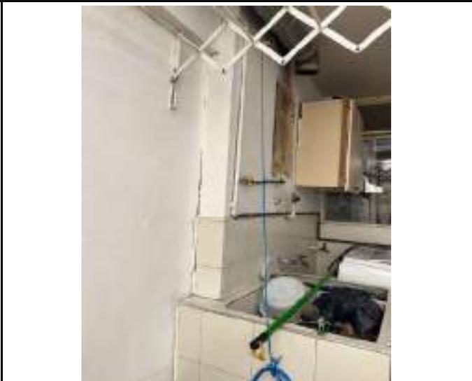
DESCRIPCIÓN: Vista en detalle fisura vertical en zona media de muro zona de unión entre enchape cuarto de ropas y muro oriental de patio interior, apartamento 101.
