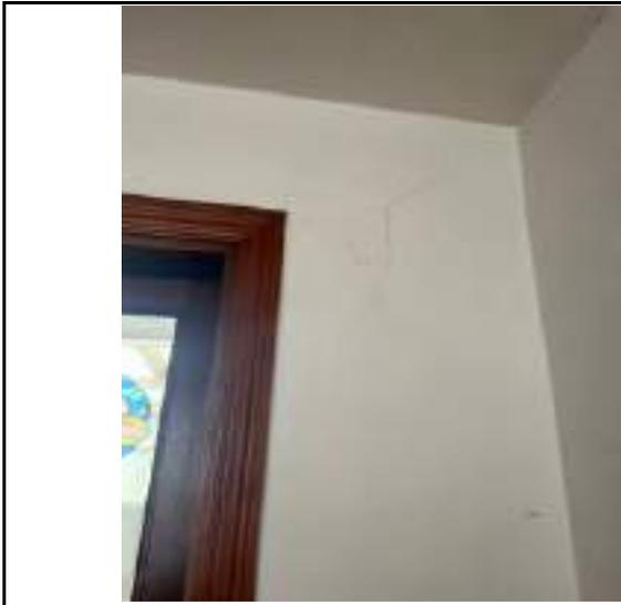
DESCRIPCIÓN: Vista en detalle fisura diagonal en parte alta de muro esquina sur oriental de habitación 2.
