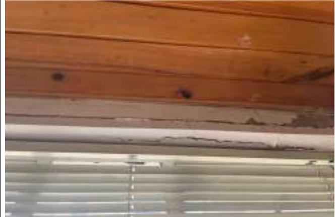
DESCRIPCIÓN: Vista en detalle fisuras horizontales, humedad y desprendimientos en parte alta de muro costado norte de estudio.
