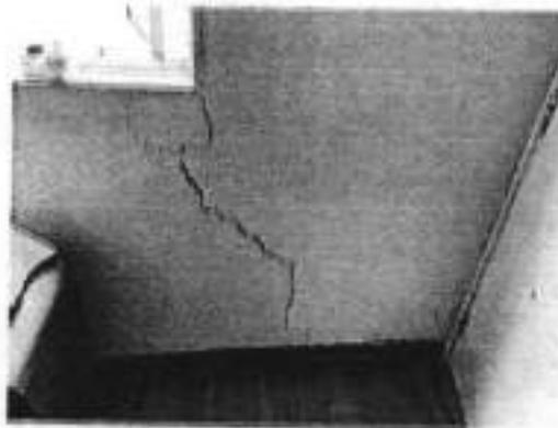
Fotografía 21. Grieta típica en muro de antepecho (costado oriental) del apartamento 301 predio P1.
