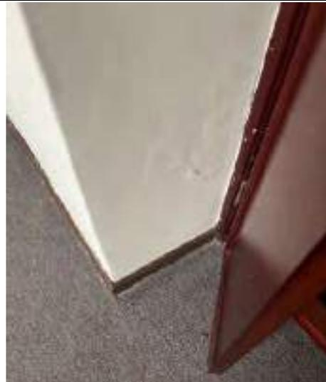
DESCRIPCIÓN: Vista en detalle humedad por filtración y embombamiento en parte baja de muro colindante con baño, costado occidental habitación 1.
