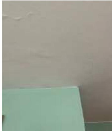
DESCRIPCIÓN: Vista en detalle fisuras en cielorraso en costado oriental zona de muro de chimenea.
