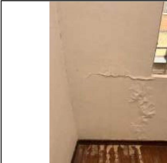
DESCRIPCIÓN: Vista en detalle fisuras, embombamientos y humedad por filtración en parte media de muro y antepecho, humedad y manchas en piso costado norte de patio interior occidental.
