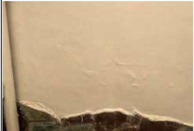
DESCRIPCIÓN: Vista en detalle aparente humedad y embombamientos en zona media de muro perimetral costado oriental de patio interior, apartamento 101.
