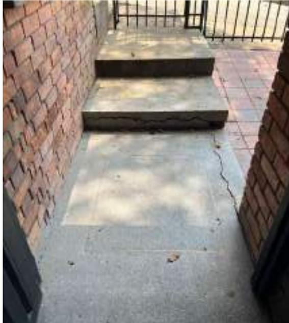
**Ilustración 21.** Se observan grietas en el corredor de acceso principal a la edificación.
