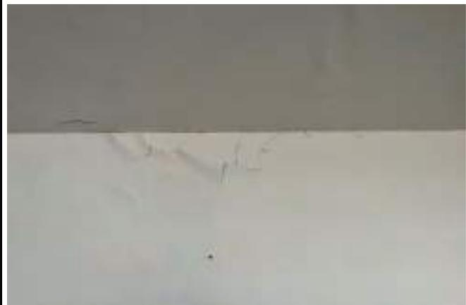
DESCRIPCIÓN: Vista en detalle fisuras y embombamientos en parte alta de muro de chimenea y cielorraso, costado norte zona de estudio.
