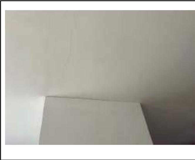
DESCRIPCIÓN: Vista en detalle fisuras horizontales en zona de unión entre muro y cielorraso.
