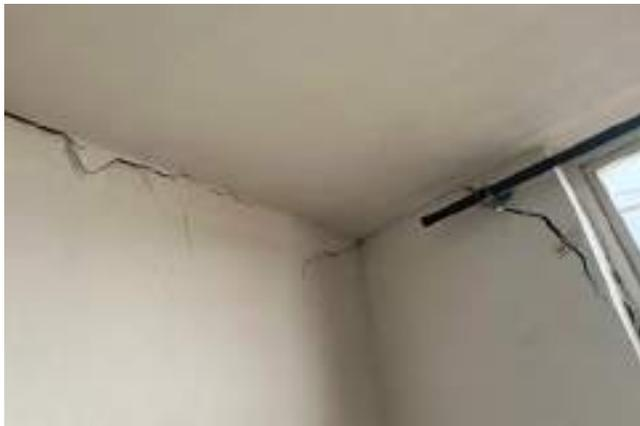
DESCRIPCIÓN: Vista en detalle fisura horizontal en cielorraso y parte alta de muro sur de habitación 2, apartamento 101.
