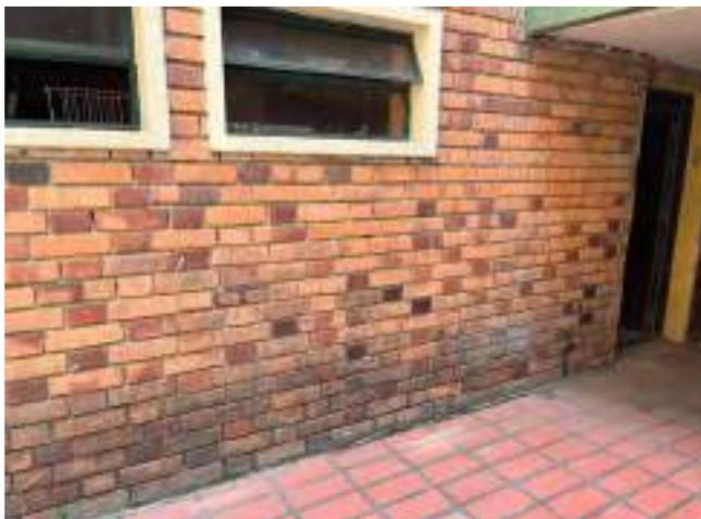
DESCRIPCIÓN: Vista en primer plano manchas y vegetación parásita en parte baja de muro en mampostería, fachada principal de edificio costado occidental.
