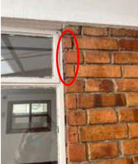
DESCRIPCIÓN: Vista en detalle fisuras en muro ostado oriental de patio interior occidental.
