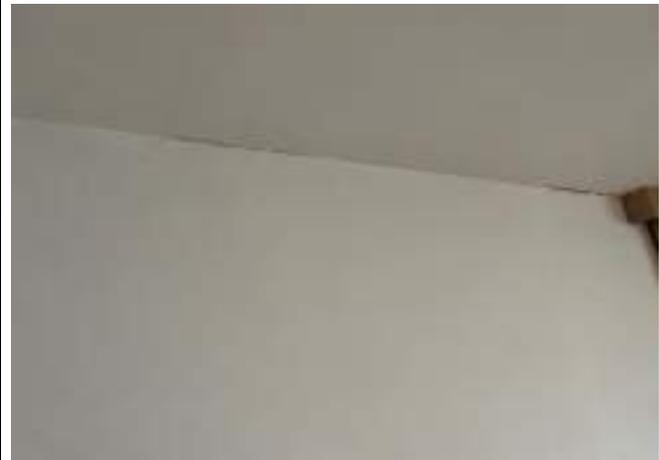
DESCRIPCIÓN: Vista en detalle fisuras horizontales en zona de unión entre muro y cielorraso en muro costado sur de habitación 1.
