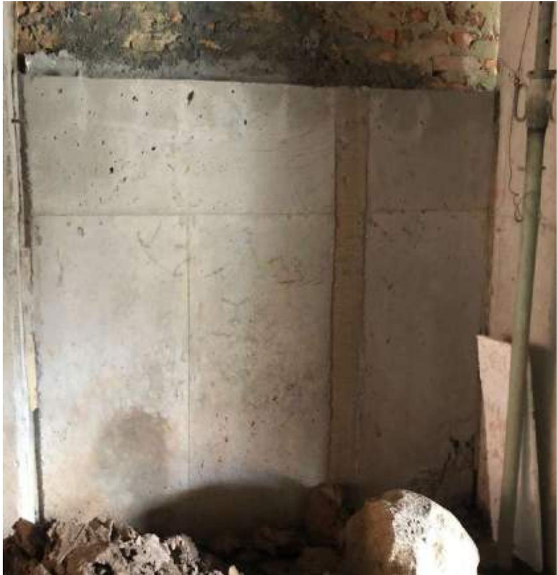
**FIG. 17 MURO DE CONTENCION FUNDIDO.**
