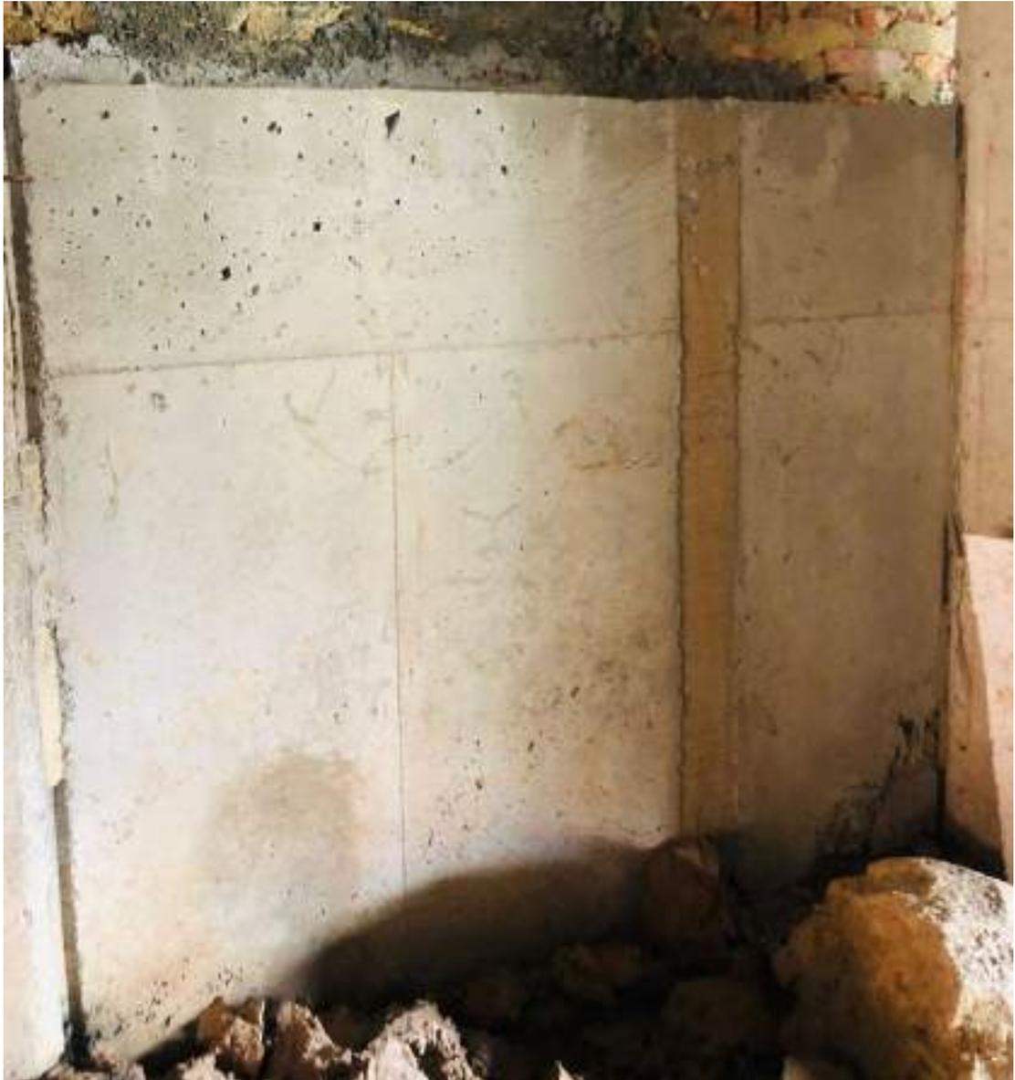
**FIG. 18 MURO DE CONTENCION FUNDIDO.**
