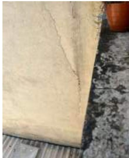
DESCRIPCIÓN: Vista en detalle grieta horizontal en costado nororiental de vacío interior oriental.
