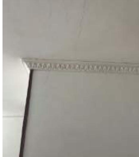
DESCRIPCIÓN: Vista en detalle fisuras en parte superior de muro chimenea en costado de occidental.
