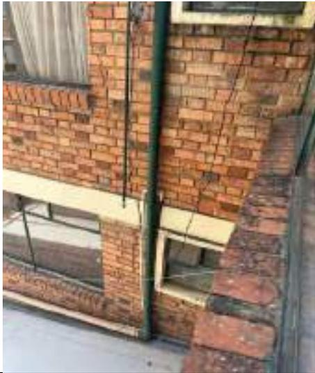
DESCRIPCIÓN: Vista en primer plano grieta vertical y diagonal y humedad por filtración muro de fachada interior occidental.
