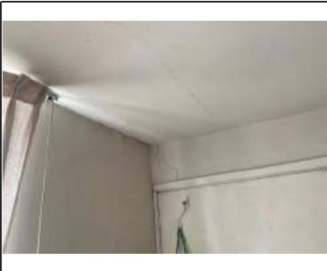
DESCRIPCIÓN: Vista en detalle grieta y fisuras diagonales en parte alta de muro y cielorraso, esquina sur occidental de habitación 1.
