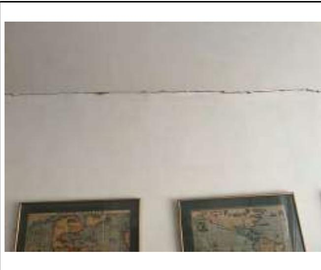
DESCRIPCIÓN: Vista en detalle fisura horizontal en zona de unión entre muro y cielorraso en costado oriental de habitación 1.
