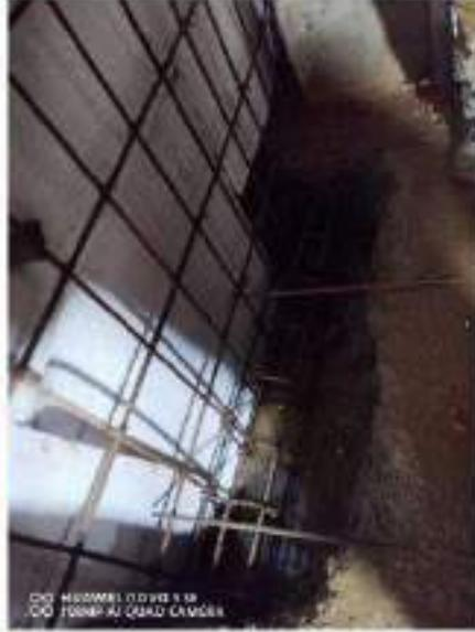
**FIG. 15 REFUERZO Y COLOCACION DE ICOPOR PARA MURO DE CONTENCIÓN.**
