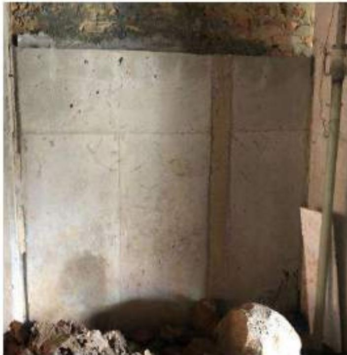
**FIG. 17 MURO DE CONTENCIÓN FUNDIDO.**
