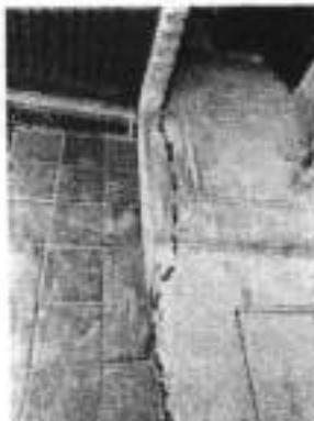
Fotografía 3. Fisuras en acabados de piso primer nivel predio P1.
