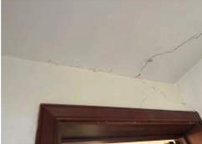
DESCRIPCIÓN: Vista en detalle grietas y fisuras en muro y cielorraso en esquina nororiental entre acceso habitación 1 y baño.
