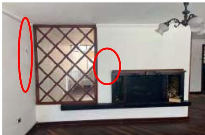
DESCRIPCIÓN: Vista en primer plano fisuras en zona media de muro de chimenea y en muro colindante en costado occidental de apartamento 101.
