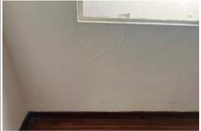
DESCRIPCIÓN: Vista en primer plano fisura diagonal en parte baja de muro costado occidental de habitación 2.
