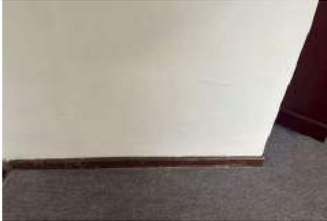
DESCRIPCIÓN: Vista en detalle humedad por filtración y embombamiento en parte baja de muro colindante con baño, costado occidental habitación 1.
