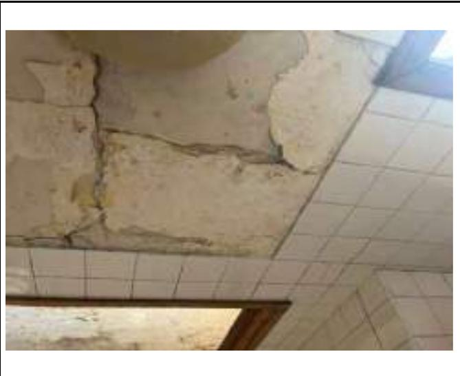
DESCRIPCIÓN: Vista en detalle fisuras, grietas, desprendimientos y humedad por filtración en cielorraso de baño principal.
