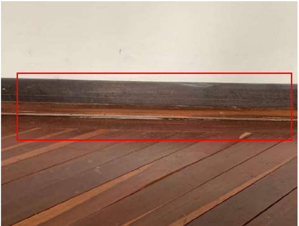
**FIG. 2 HUNDIMIENTO EN PISO DE MADERA.**
