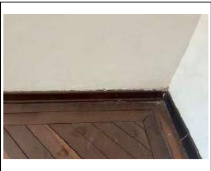
DESCRIPCIÓN: Vista en detalle fisura horizontal en parte baja de muro, habitación 3.
