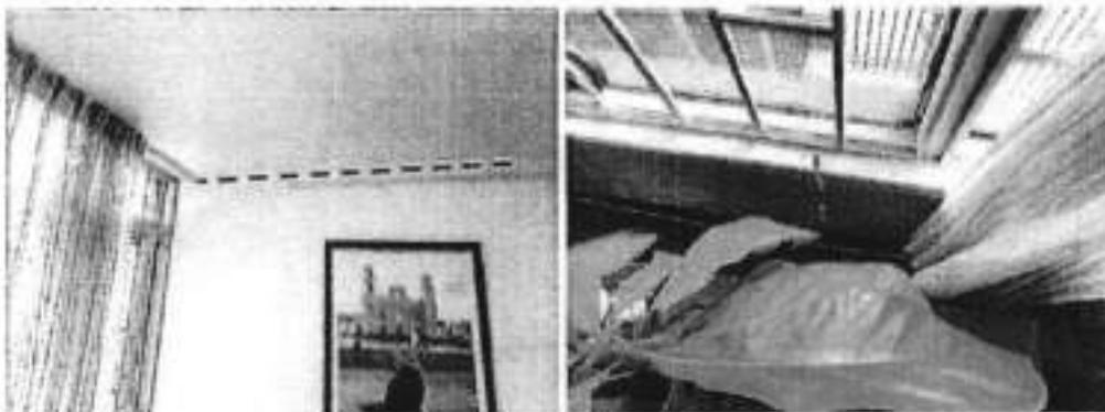
Fotografías 27 y 28. Fisuras en vértices entre placa de entepiso y muros perimetrales del apartamento 101 predio P1.
