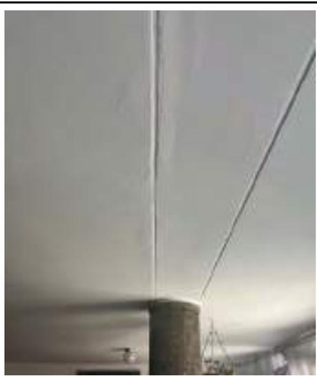
DESCRIPCIÓN: Vista en detalle fisuras longitudinales en cielorraso en zona de unión con viga.
