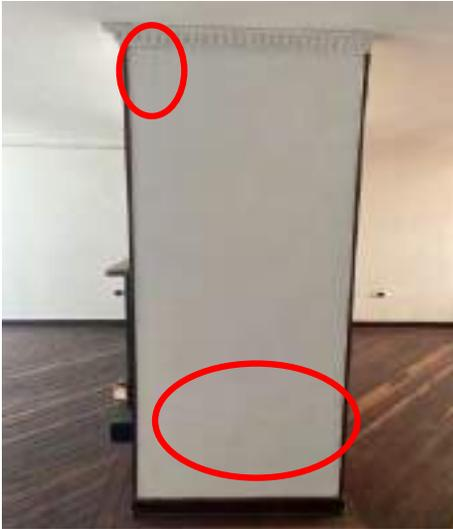
DESCRIPCIÓN: Vista en primer plano costado oriental de muro de chimenea, se observan fisuras.
