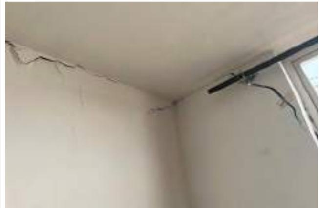
DESCRIPCIÓN: Vista en detalle fisura horizontal en cielorraso y parte alta de muro sur de habitación 2, apartamento 101.
