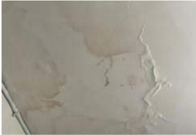
DESCRIPCIÓN: Vista en detalle fisuras en cielorraso, manchas, humedad por filtración y embombamiento en costado noroccidental de zona de ropas.
