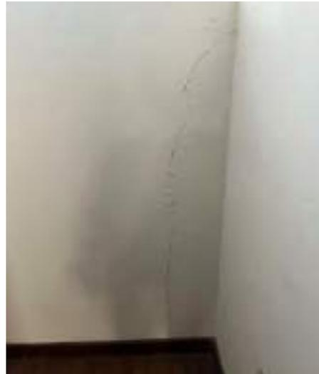
DESCRIPCIÓN: Vista en detalle fisura vertical en muro costado sur en depósito de cocina, apartamento 101.
