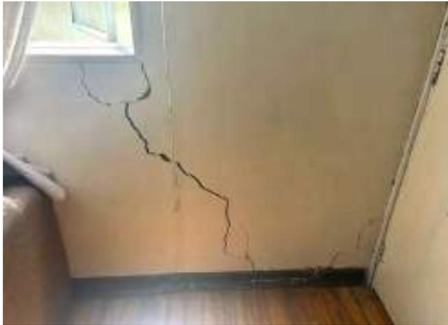
DESCRIPCIÓN: Vista en detalle grieta y fisuras diagonales en parte baja y media de muro, esquina sur occidental de habitación 1.
