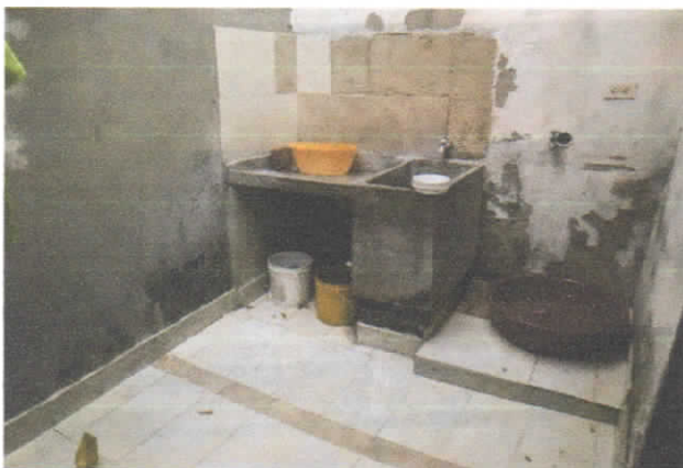
PATIO DE ROPAS
