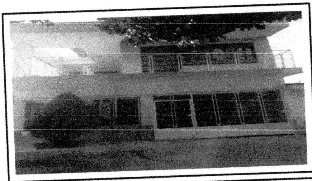
DETALLE DE LA FACHADA
