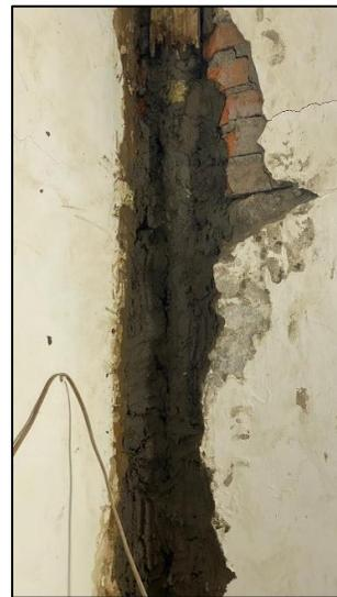
Estado Actual: Se encontró la instalación de un bajante de agua lluvia. (fotos del proceso constructivo suministradas por el arrendatario).
