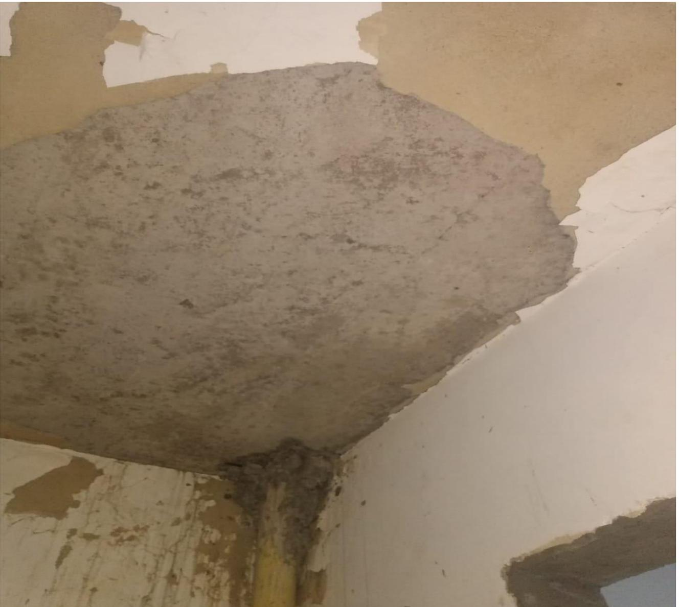
Filtración del tanque aéreo de uno de los baños, que al parecer se debe demoler sino se logra sellar la filtración y que pone en peligro a cualquier persona que se encuentre en ese baño usándolo.
