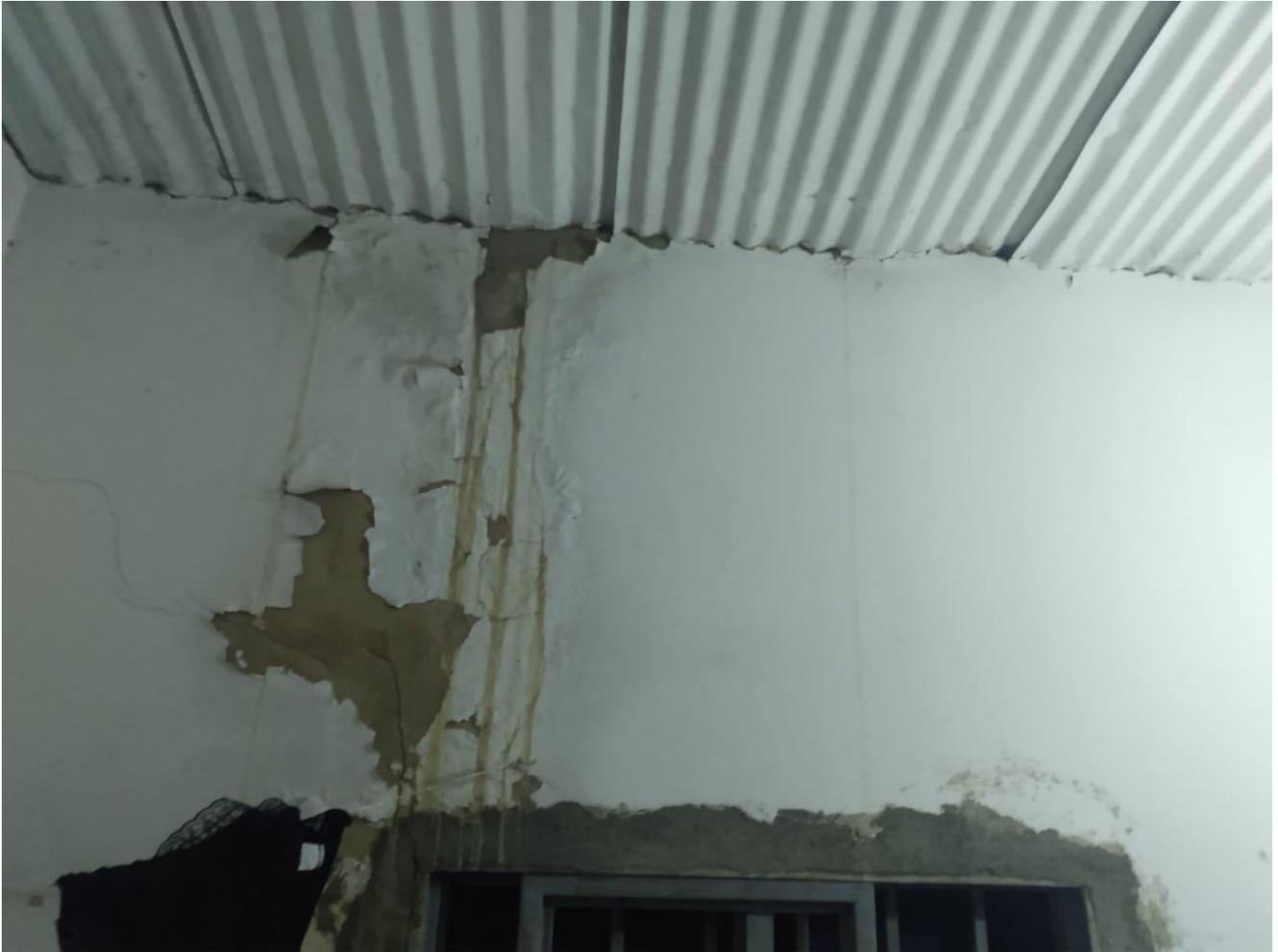
Muro de una de las alcobas donde aprecia la filtración de agua cuando llueve lo que hace que la mejora se vea en mal estado de uso y conservación
