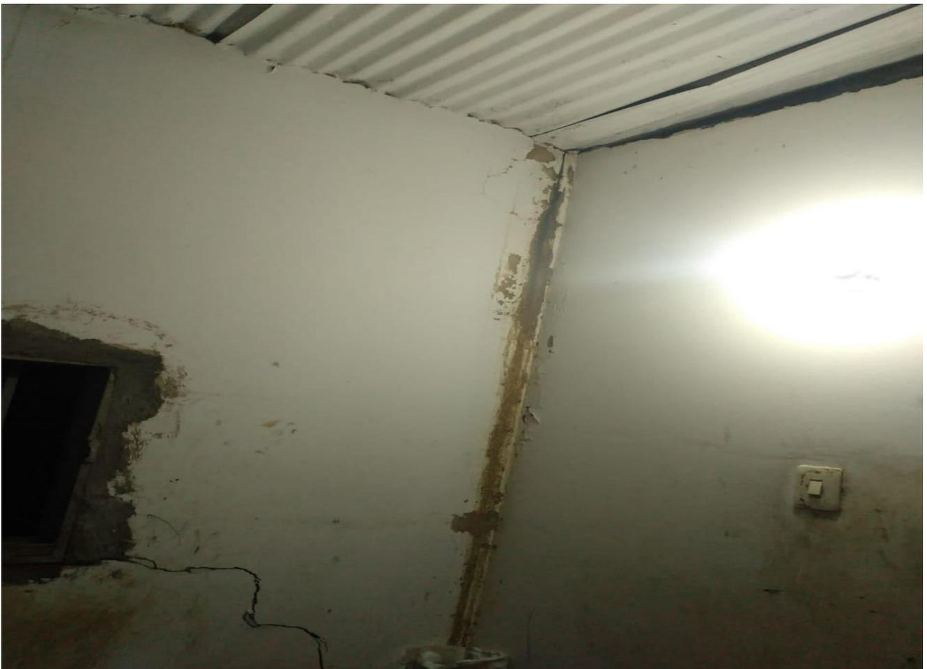
Muro de una de las alcobas que están al fondo de la mejora, donde se puede apreciar las filtraciones de agua y se ve partido el muro.
