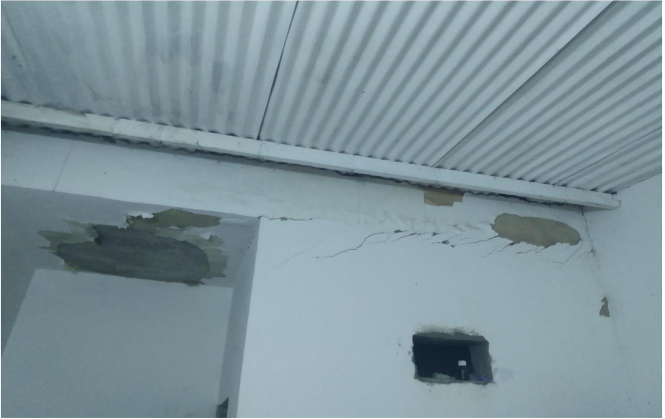
Se observa el muro que llega hasta techo donde se aprecia filtraciones y que se encuentra partido
