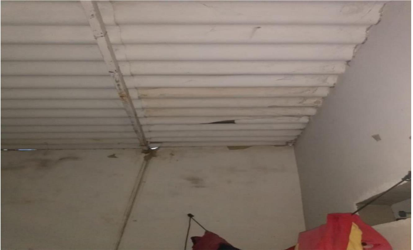
Parte del techo de la mejora donde se puede apreciar las filtraciones que tiene (huecos)
