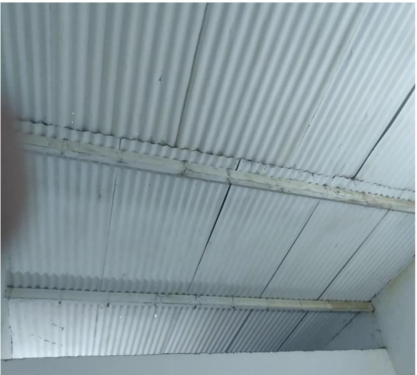
Parte de la cubierta de la mejora en ZINC donde se aprecia el mal estado y los huecos por donde pasa la luz del sol y el gua cuando llueve
