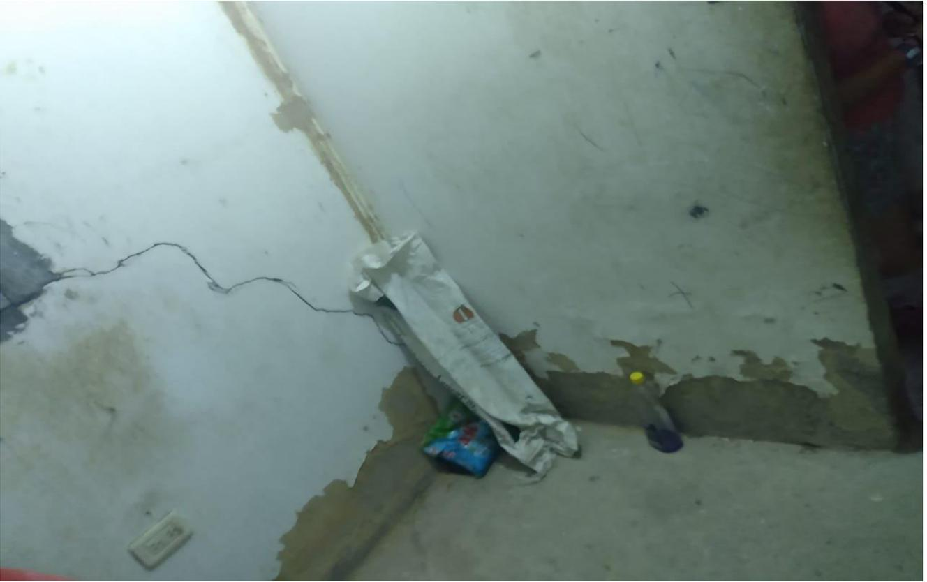
Se aprecia el estado de deterioro de los muros de la mejora debido a la filtración del agua
