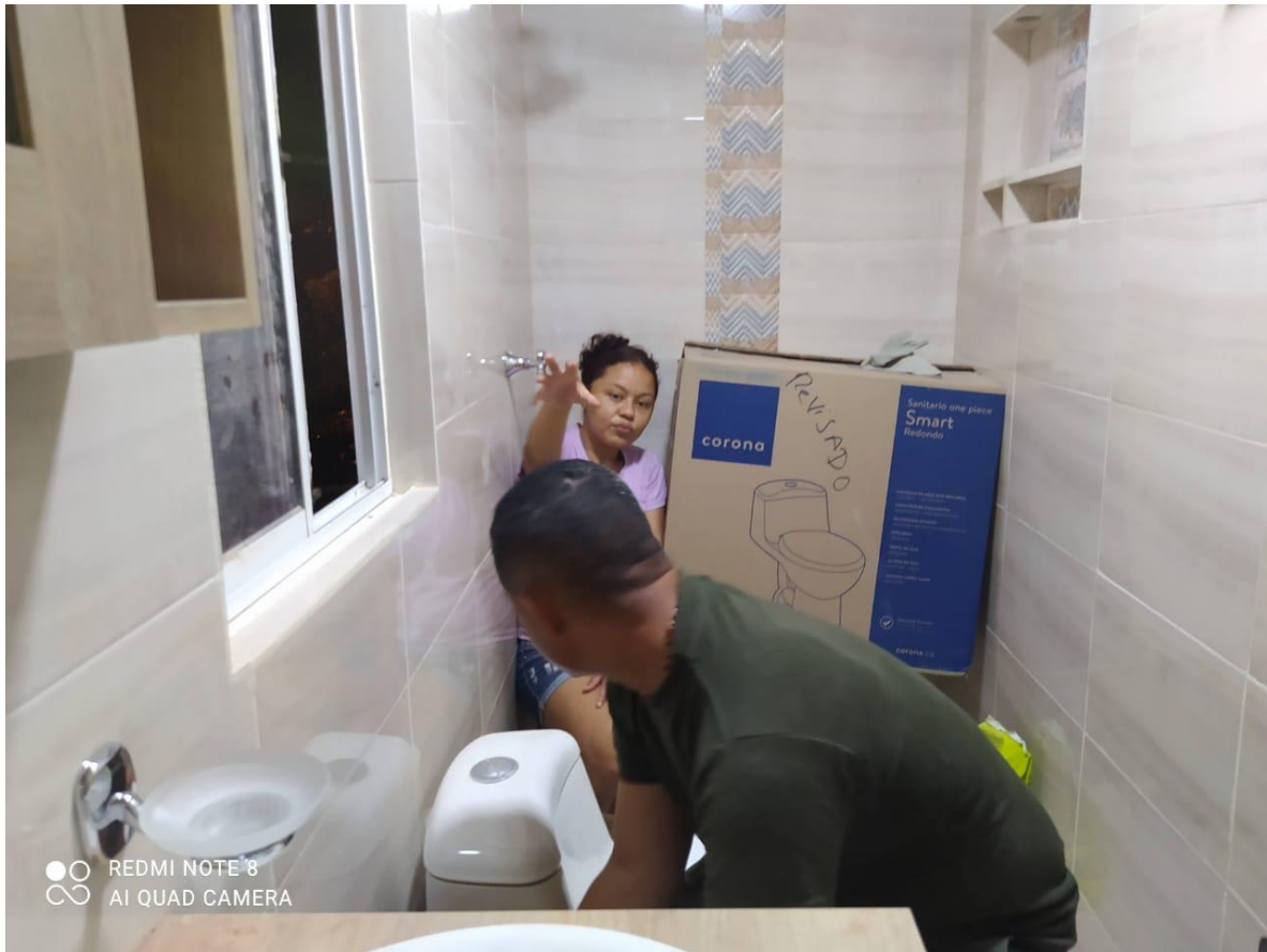
Foto 3. Arreglo del baño mes de diciembre 2021, en la imagen LOIS PEDRAZA Y HERNAN GUILLERMO MOSCOTE
