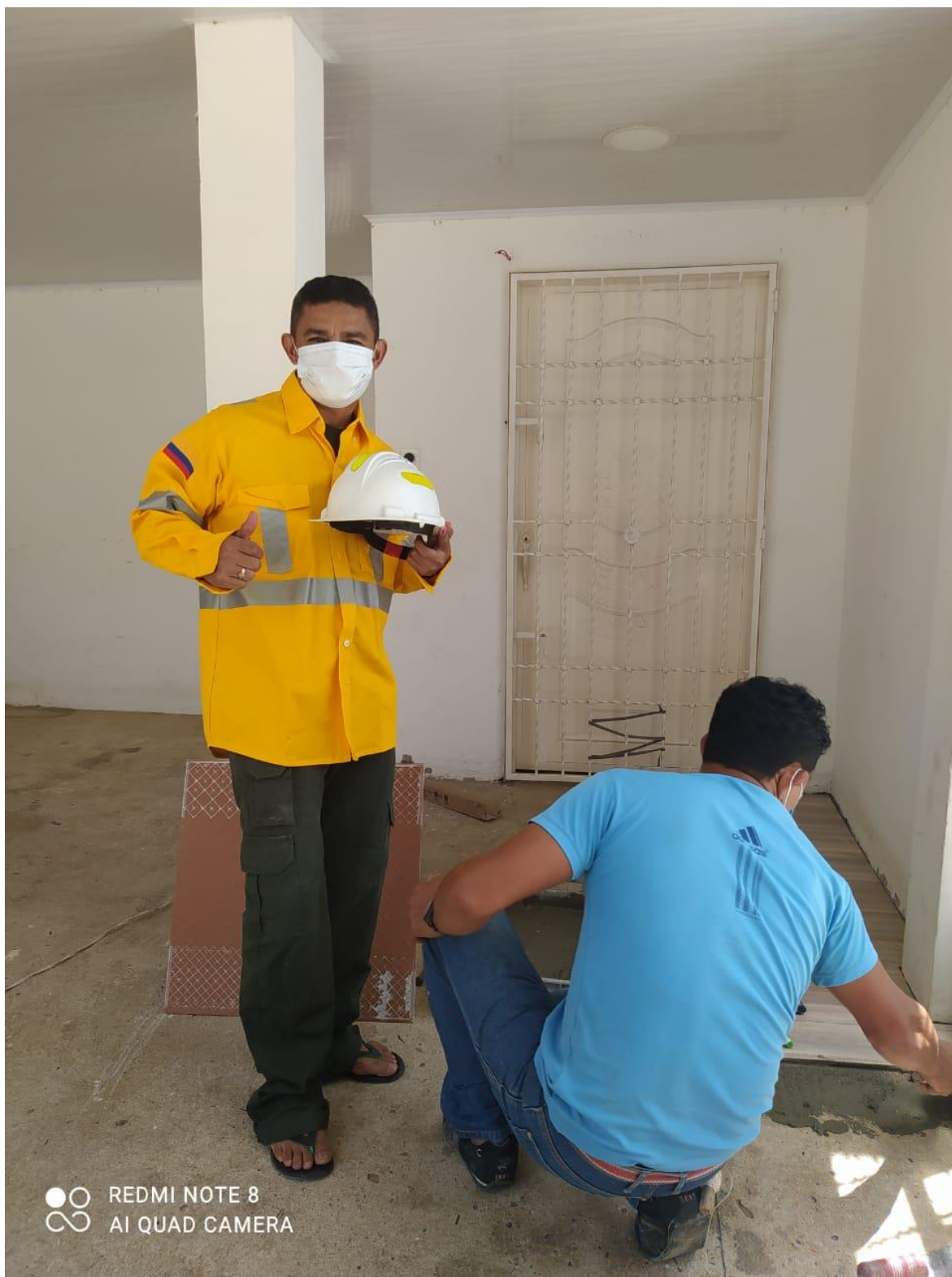
Foto 2- Arreglo de la terraza de la vivienda. De amarillo en la imagen el Sr. HERNAN GUILLERMO MOSCOTE NIETO, año 2021.
