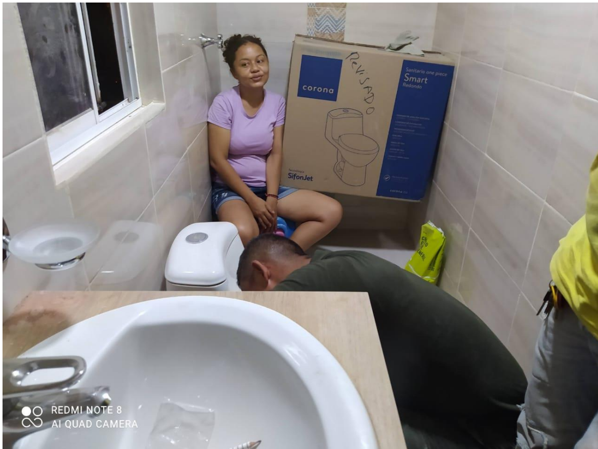
Foto 4. Arreglo del baño mes de diciembre 2021, en la imagen LOIS PEDRAZA Y HERNAN GUILLERMO MOSCOTE.
