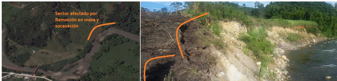
Registro fotográfico 1: Características y magnitud del evento de remoción en masa que se presentó en la vía Timaná – Pitalito.
