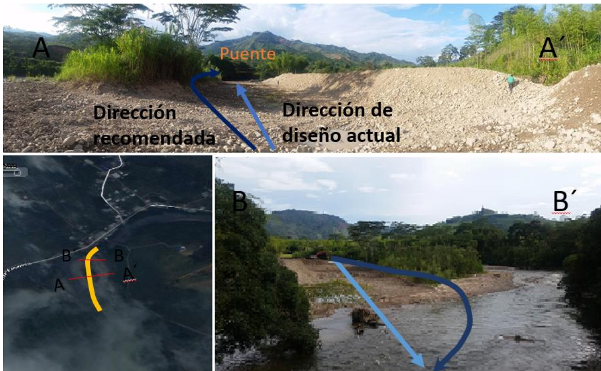
Registro fotográfico 3. Detalles del proceso de dragado sector San Marcos.
