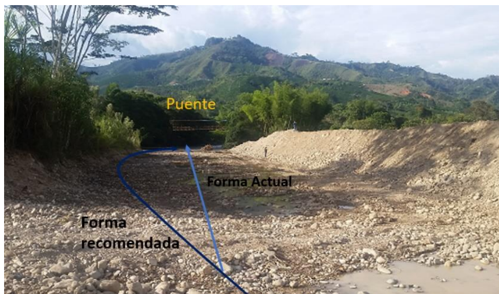
Registro Fotográfico 2. Canal de dragado en construcción, al fondo puente sobre el río
