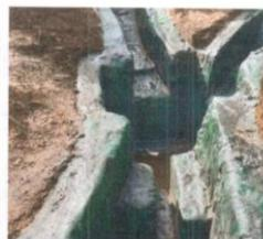
Fig. 42 - Instalación de POLIMEX para zanja de contracción, caso con obstáculo de agua y dispersión con hombrón en la salida y entrego a la quebrada
