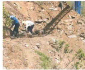
Fig. 40 - Apertura de camino en conglomerados necesaria para transportar materiales requeridos en la obra.
