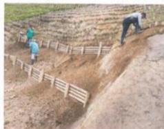
Fig. 43 - Construcción e instalación de brichos en gualta como elemento de estabilización del terreno.
