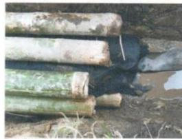
Fig. 44 - Construcción e instalación de filtros vivos en guatúa recubierta con geotextil
