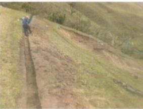
Fig. 41 - Apertura de la zanja colectora para la instalación del POLIMEX.
