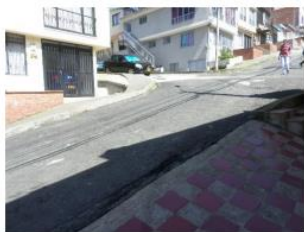
6. Calle 57C1 Carrera 8ª1. En el sitio se realizó mantenimiento del pavimento mediante parcheo en asfalto con el fin de corregir unos fallos que se encontraban en el sitio. Como puede observarse, con dicho parcheo se mejoró ostensiblemente la movilidad tanto peatonal como vehicular por el sector.
