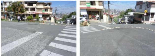
6. Calle 57C1 Carrera 8ª1. En el sitio se realizó mantenimiento del pavimento mediante parcheo en asfalto con el fin de corregir unos fallos que se encontraban en el sitio. Como puede observarse, con dicho parcheo se mejoró ostensiblemente la movilidad tanto peatonal como vehicular por el sector.
