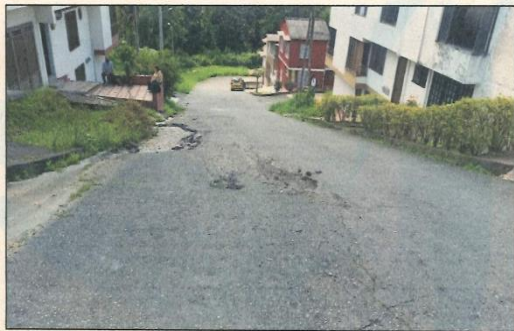
Deterioro de pavimento en la calle 57D entre carreras 7 y 8 barrio Villa Café
