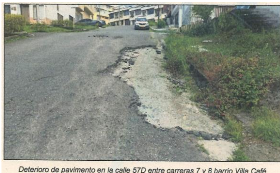
Deterioro de pavimento en la calle 57D entre carreras 7 y 8 barrio Villa Café
