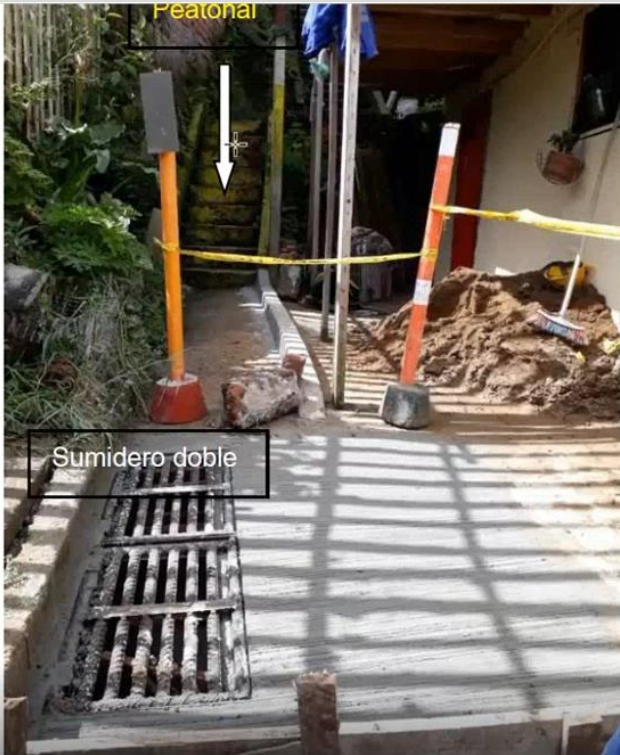
Foto 3 y 4: Sumidero doble reubicado en la parte baja de la peatonal del sector y reconstrucción de la peatonal
