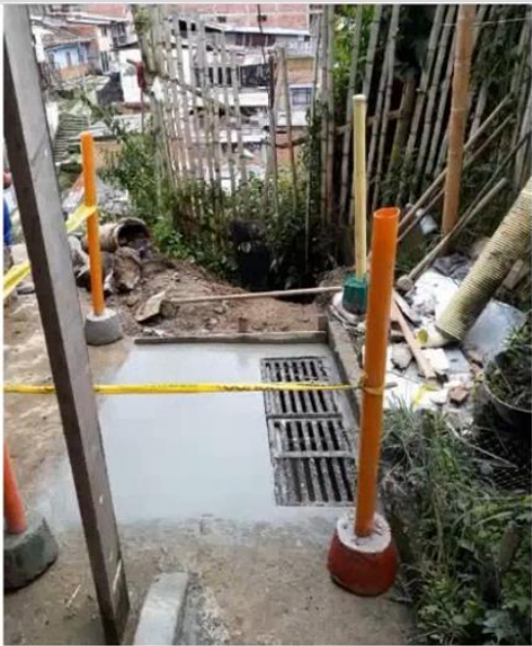
Foto 3 y 4: Sumidero doble reubicado en la parte baja de la peatonal del sector y reconstrucción de la peatonal
