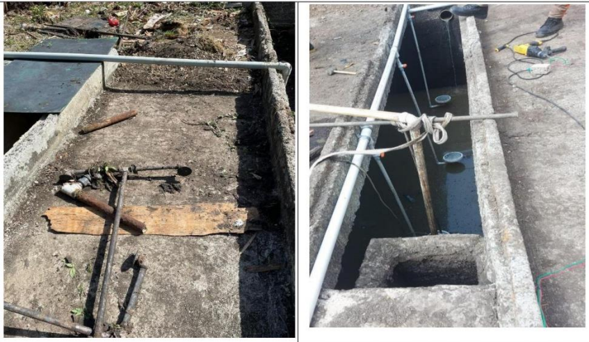
ANTES: Sistema de difusores no funcionales DESPUES: Suministro e instalación de difusores nuevos
