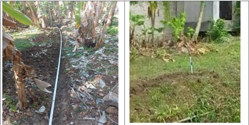
ANTES: No se contaba con sistema de aspersores funcional DESPUES: Suministro e instalación de red hidráulica y aspersores
