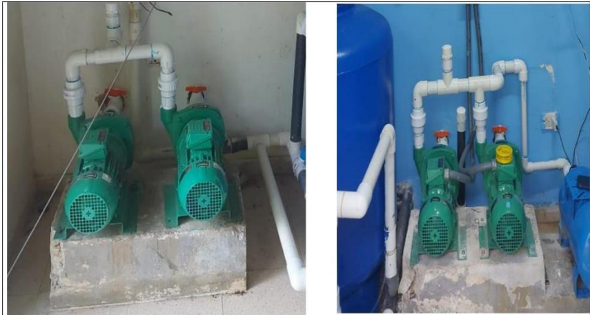
DESPUES: Suministro e instalación de bombas centrifugas
