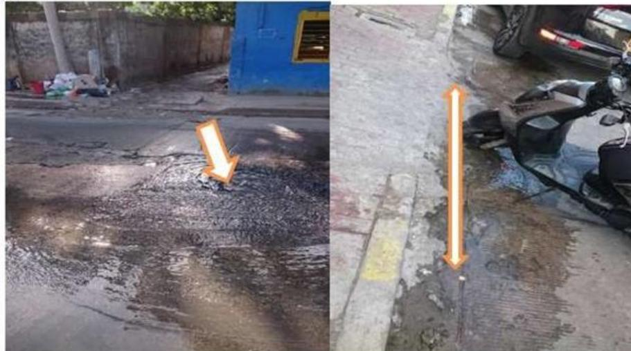
FOTO No 11. Presencia de elementos " bafe de sonido" en la carretera junto a la rejilla por donde se dirige el agua servida junto al andén
