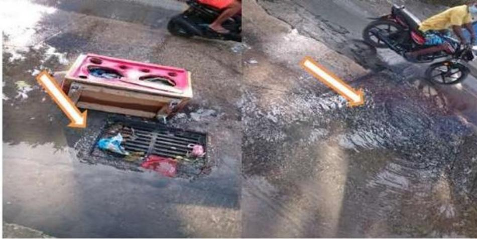
FOTO No 12. Vertimiento de las aguas residuales procedente del registro o Manhole que se dirige a la calle de Rock Hole por donde se encuentra los establecimientos Comerciales de materiales para construcción
