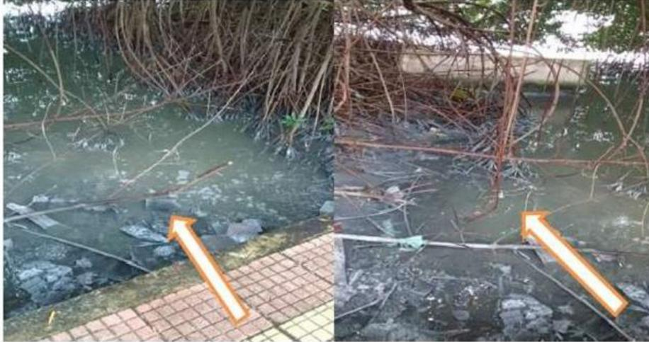
Foto No 10 Rebosamiento del registro o Manhole hacia la calle con emisión de olores ofensivos, esta infraccion es constante en este sitio
