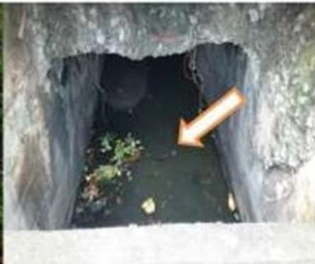
FOTO No 4. Carencia de una losa de cubrimiento del Box Covert y Presencia de residuos sólidos por la rejilla donde es vertido las aguas residuales
