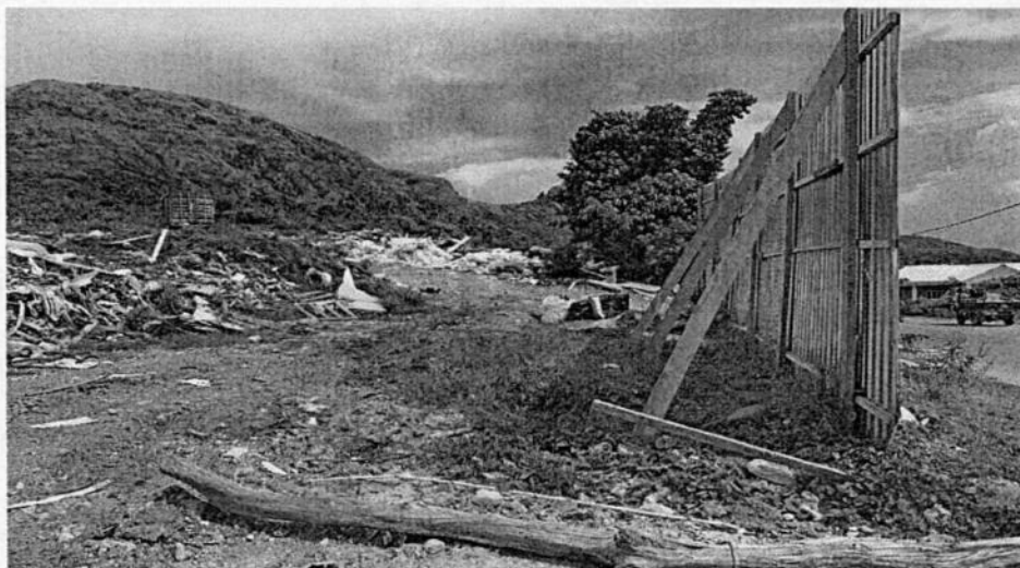
Imagen 3 no se encuentra encerramiento lado izquierdo del acopio 2.
