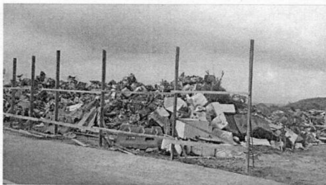
Adecuación para un posible encerramiento
