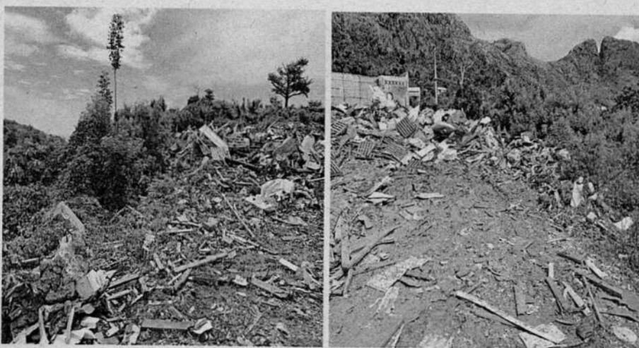
Imagen 4 no se encuentra encerramiento lado izquierdo del acopio
