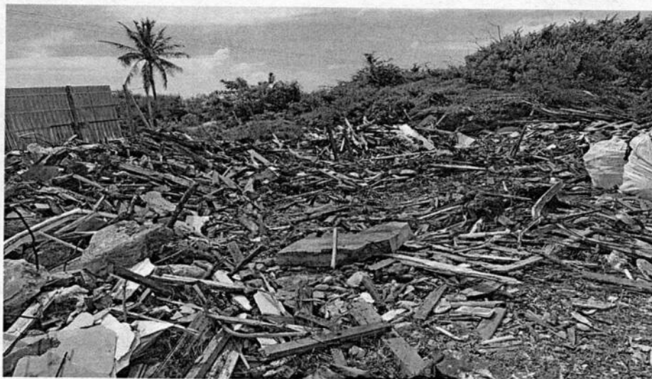
Imagen 2 estado actual centro acopio 2
