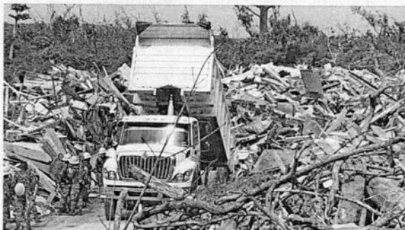
Camión descargando residuos
