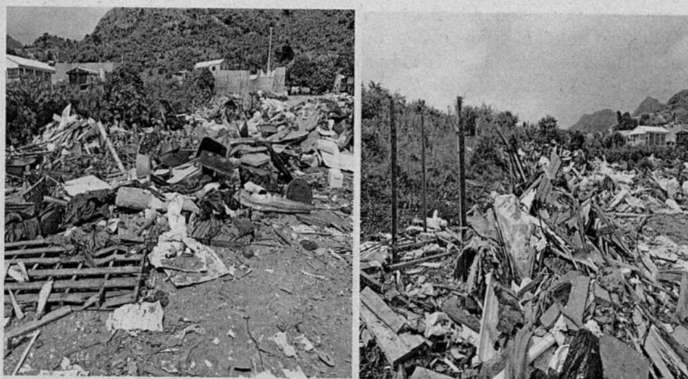
Imagen 5 no se encuentra encerramiento lado derecho del acopio 1.
