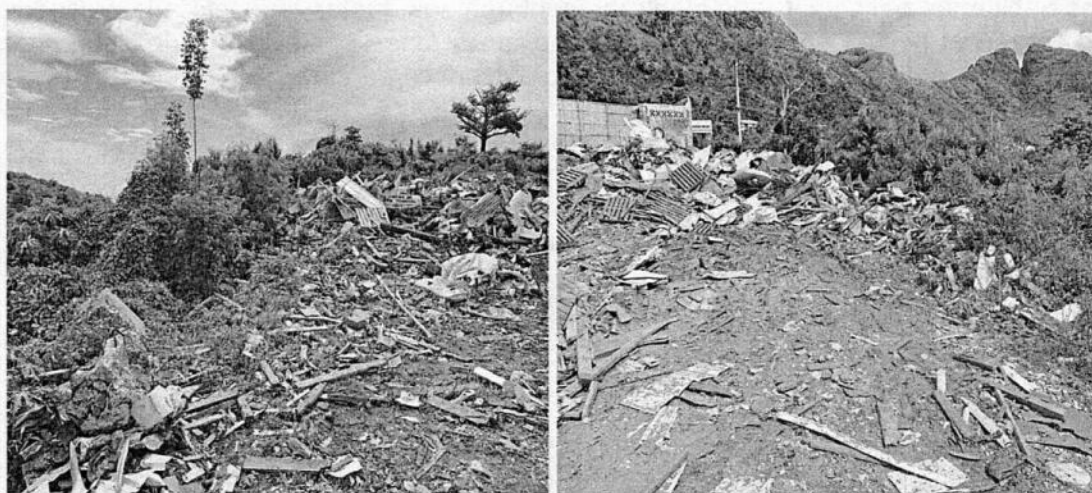
Imagen 4 no se encuentra encerramiento lado izquierdo del acopio 1.
