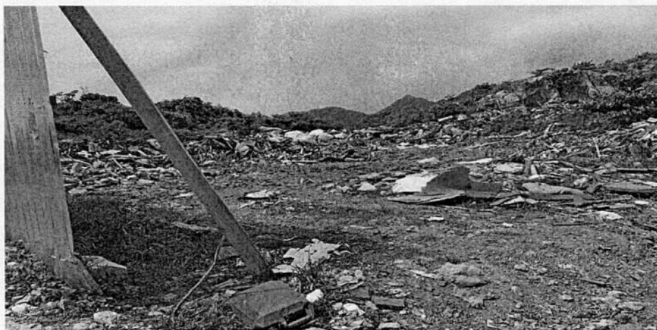
Imagen 4 no se encuentra encerramiento lado derecho del acopio 2.
