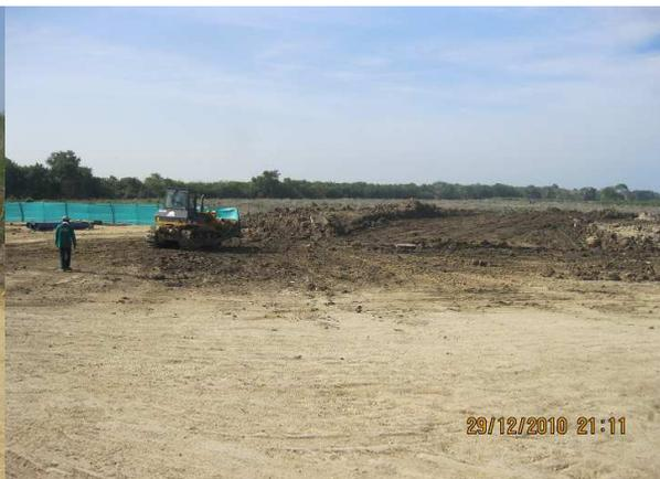
Se retomaron las actividades en el muelle y se inicio el relleno de oeste a este, retirando con la retroexcavadora todos los sedimentos del mangle.
