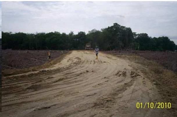
Para la actividad de limpieza del canal se contrato una retro excavadora 320. Se retiro el material de sedimentación, rectificación de sección del canal.
