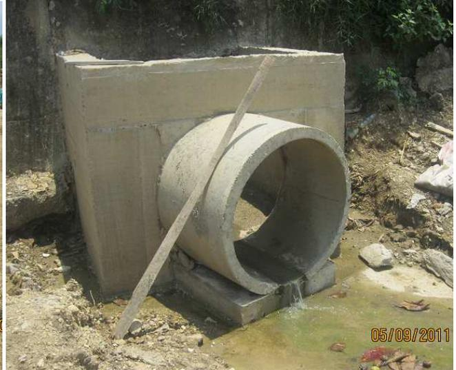
2. Se realizo la cimentación del alcantarillado, para proceder a la instalación de la tubería.
