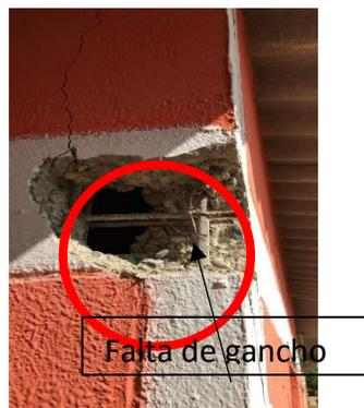
Esto significa que la cuantía exigida es del orden de  $0.71\text{cm}^2 \times 4 = 2.84\text{cm}^2$  para cada columneta, mientras que la existente es de  $0.57\text{cm}^2 \times 4 = 2.28\text{cm}^2$ . Lo anterior plantea una diferencia de  $0.56\text{cm}^2$  de acero (1 barra adicional de 3/8) "para la sección de 10cm x 20cm, respecto al título E. Esto se deberá verificar y avalar por el informe estructural consensuado con el ingeniero asesor de la alcaldía municipal.
