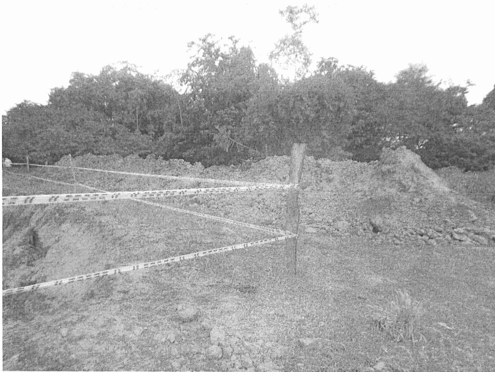
Excavacion dentro del Predio Perico para tubería nueva de Ecopetrol
