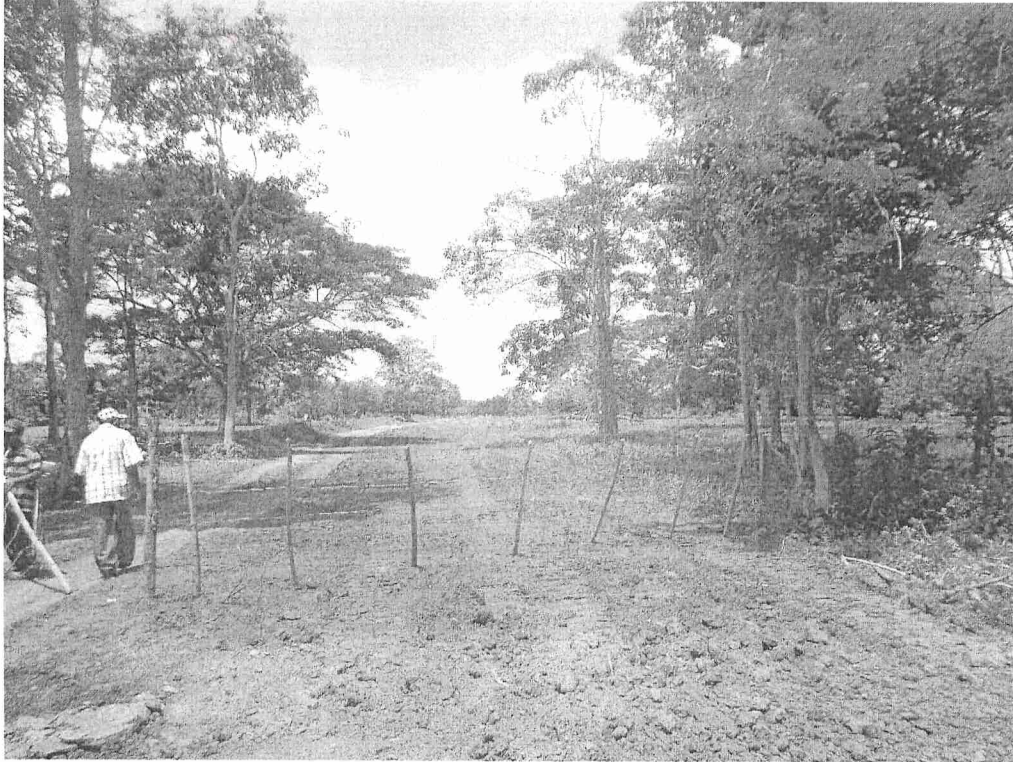
Comienzo de las medidas de las tuberías en el predio PERICO
