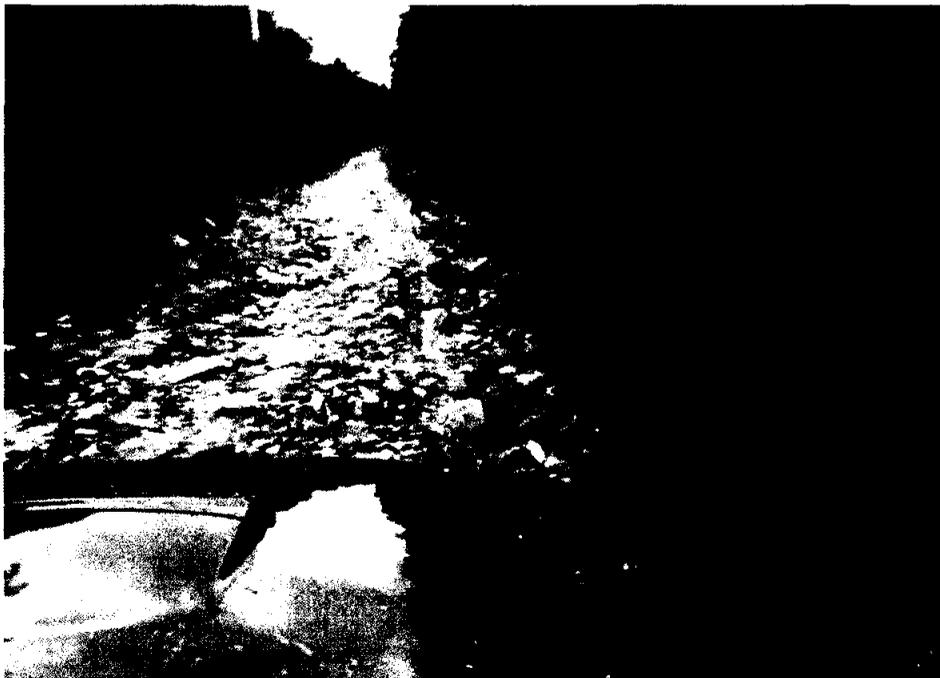
Se observa por efectos de la lluvia la erosión y arrastre del material seleccionado que en su momento fue colocado, se observa un espesor aproximado de 0,22 m.
