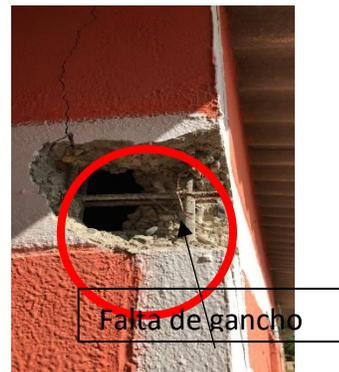
Esto significa que la cuantía exigida es del orden de  $0.71\text{cm}^2 \times 4 = 2.84\text{cm}^2$  para cada columneta, mientras que la existente es de  $0.57\text{cm}^2 \times 4 = 2.28\text{cm}^2$ . Lo anterior plantea una diferencia de  $0.56\text{cm}^2$  de acero (1 barra adicional de 3/8) "para la sección de  $10\text{cm} \times 20\text{cm}$ , respecto al título E. Esto se deberá verificar y avalar por el informe estructural consensuado con el ingeniero asesor de la alcaldía municipal.
