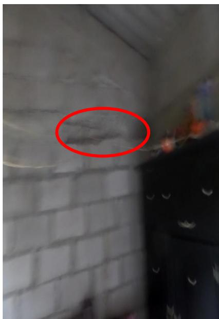
Solución planteada: picar el concreto, adicionar el refuerzo requerido en barras de 3/8" con sus respectivos traslapos y llevarlo hasta alcanzar el nudo con las columnetas respetivas.
