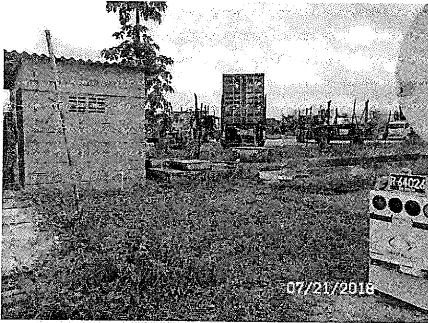
FOTO No. 9 TANQUE ENTERRADO
