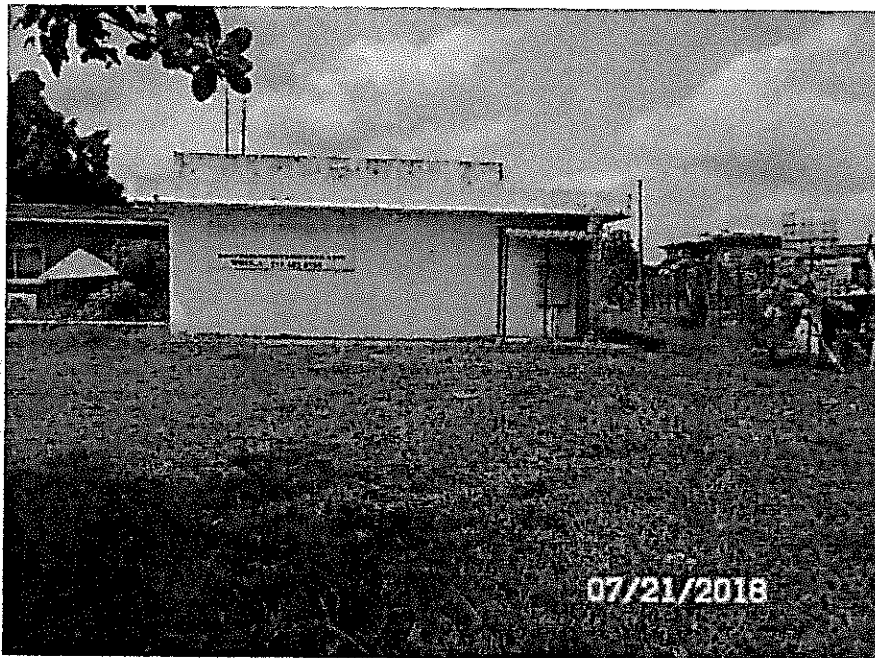
FOTO No. 13 FACHADA LATERAL DERECHA OFICINA
