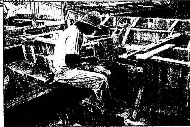
CONTENIDO: REFORZAMIENTO, Y APUNTALAMIENTO DE GUARDERAS
