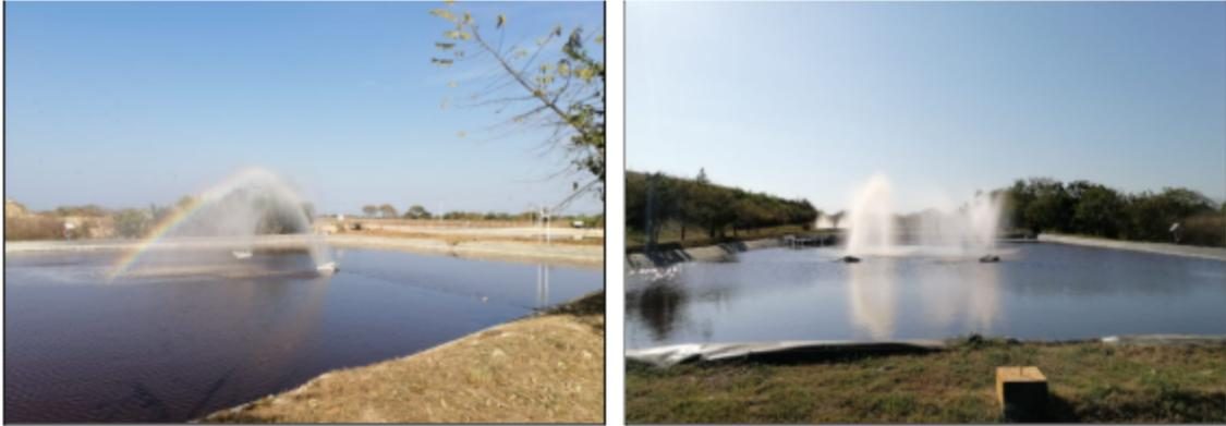
Fotografía N° 3: Proceso de aspersion controlada y recirculación de lixiviados.
