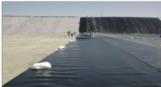
Fotografía N° 1: Proceso de Impermeabilización con geomembranas de alta densidad.
