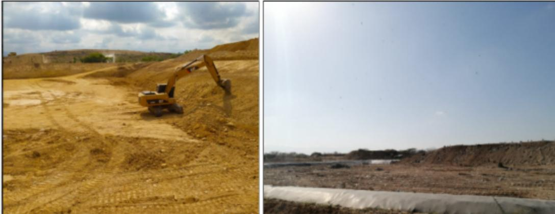
Fotografía N°2: Cubrimiento de residuos con material arcilloso y terrazas conformadas
