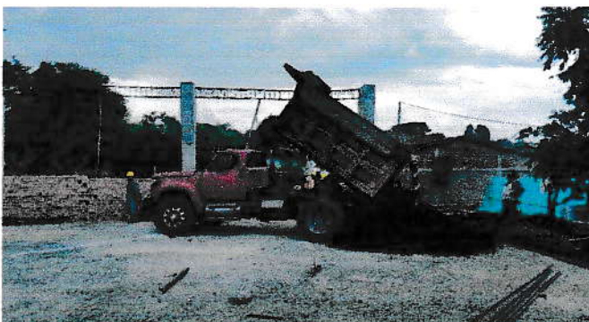
F.12. TRANSPORTE Y SUMINISTRO DE MATERIAL DE SUB-BASE
