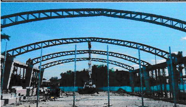
F.6. ESTRUCTURA DE CUBIERTA
