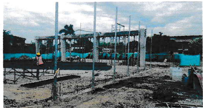
F.4. COLUMNAS, VIGA AEREA, VIGA DE CIMENTACION DE MURO CONTRAIMPACTO Y TUBERIA DE MURO CONTRAIMPACTO
