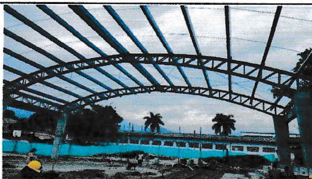
F.2. ESTRUCTURA DE CUBIERTA
