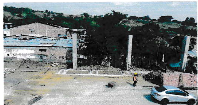
F.6. VIGAS DE CIMENTACION DE GRADERIAS
