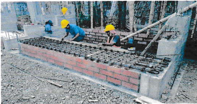
F.3. ACERO DE PLACAS EN CONCRETO, MUROS LATERALES Y MURO EN LADRILLO
