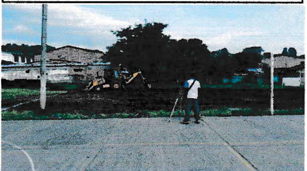
F.6. EXCAVACION Y CHEQUEO DE EXCAVACION CON NIVEL DE PRECISION
