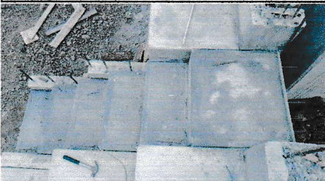
F.5. GRADAS EN GRADERIA
