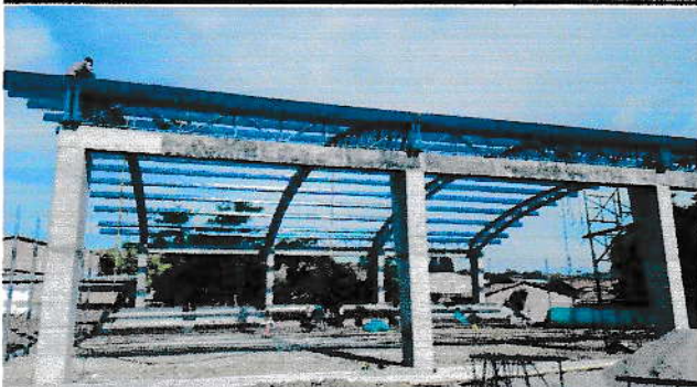
F.3. ESTRUCTURA DE CUBIERTA
