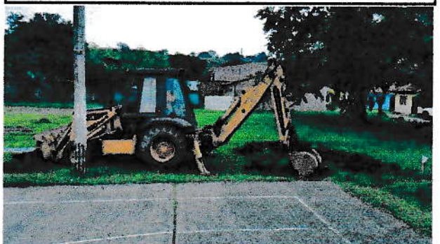
F.4. INICIO DE OBRA, EXCAVACION. ( SE OBSERVA POSTE CON ALUMBRADO PUBLICO
