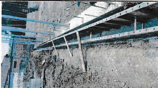
F.1. FORMALETA PARA CANAL DE AGUAS LLUVIAS EN CONCRETO PERIMETRAL A LA LOSA DE CONCRETO
