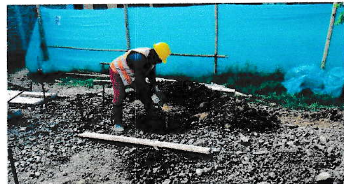
F.8. EXCAVACION DE PILOTES PARA VIGA DE CIMENTACION MURO CONTRAIMPACTOS
