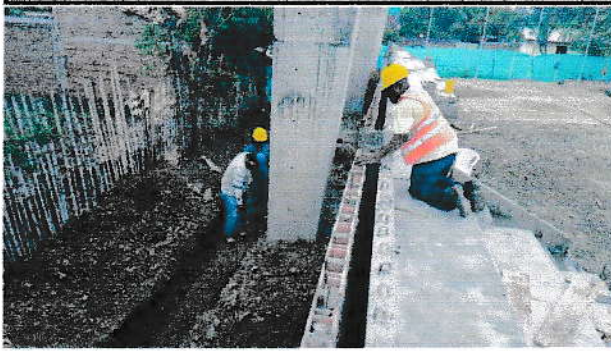
F.4. ACERO PARA CANAL DE AGUAS LLUVIAS Y ESTRUCTURA DE GRADERIA
