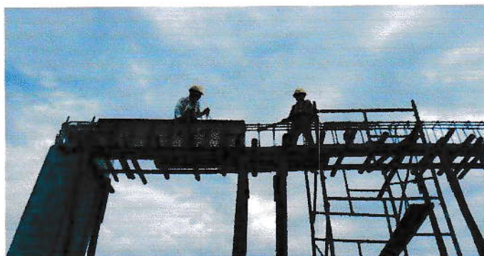
F.7. AMARRE DE ACERO Y FORMALETA DE VIGA AEREA. LOS AYUDANTES CON LINEAS DE VIDA
