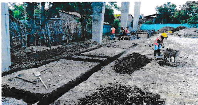
F.5. EXCAVACION DE VIGAS DE CIMENTACION DE GRADERIA
