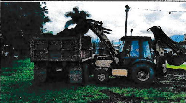
F.5. EXCAVACION Y RETIRO DE MATERIAL PRODUCTO DE LA MISMA
