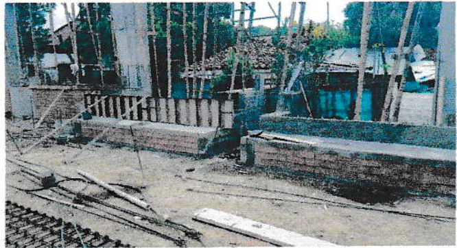
F.2. PLACAS EN CONCRETO GRADERIAS Y MURO EN LADRILLO
