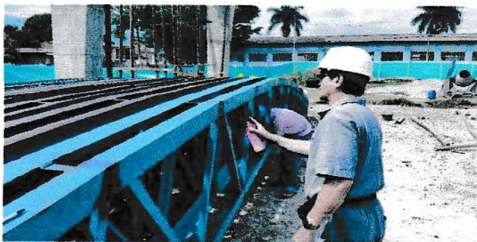
F.9. ENSAYO DE TINTAS PENETRANTES EN OBRA, PARA ESTRUCTURA DE CUBIERTA
