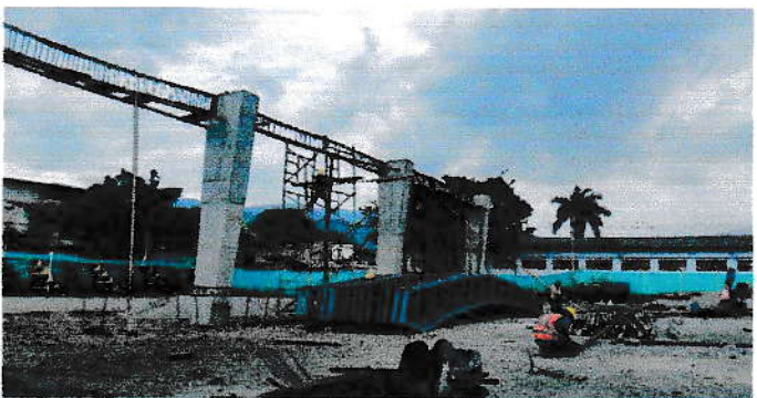
F.11. COLUMANAS, ACERO Y FORMALETA VIGAS AEREAS. ESTRUCTURA DE CUBIERTA EN OBRA
