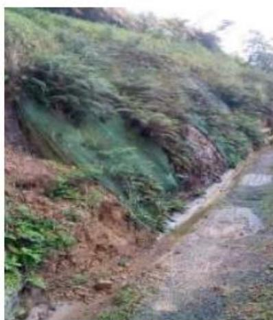
Imagen 3: desestabilización y desprendimiento de materiales del talud
