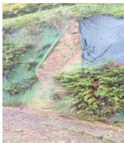
Imagen 4: desprendimiento de materiales del talud.
