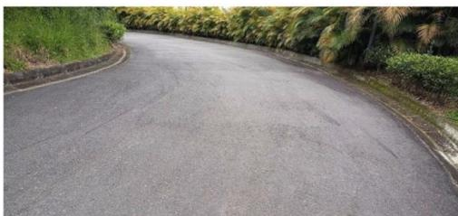
Buen estado general de las vías del conjunto. No se observan discontinuidades, grietas, ausencia de elementos de drenaje.
