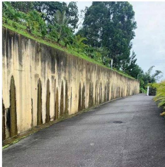
Aspecto del muro de contención construido en la parte alta del conjunto en general en buenas condiciones, afloramientos de agua indicativos de que los drenes se encuentran en funcionamiento.
