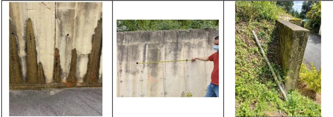
En esto coincidió el ingeniero Hernán Barón Méndez, quien elaboró el diseño del muro; él declaró: "en el muro de contención de concreto reforzado evidenció que faltan los drenes horizontales y los lloraderos para permitir la salida del agua que se acoplaba en la parte de atrás del muro... nunca pude evidenciar si se hizo detrás del muro el filtro y... el relleno de manera adecuada para sacar estas aguas" (min. 1:01:17, archivo 20060714--0028100002, carpeta 34).
