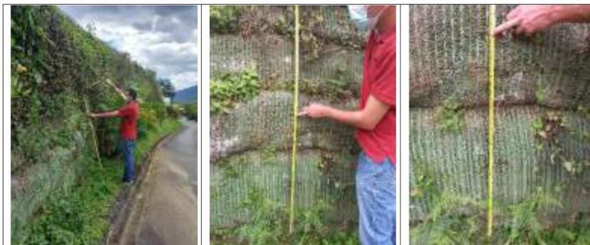
Taludes de tierra armada que no cumplen con los espesores ni con la inclinación
