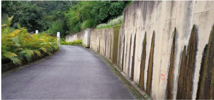
Vía superior del conjunto, muro de confinamiento de ladera superior, aplomado, con cuneta de piso. No se observan signos, o evidencias de movimientos que pudieran afectar la zona y que claramente se verían reflejadas de forma notoria en muros, vías y cunetas.
