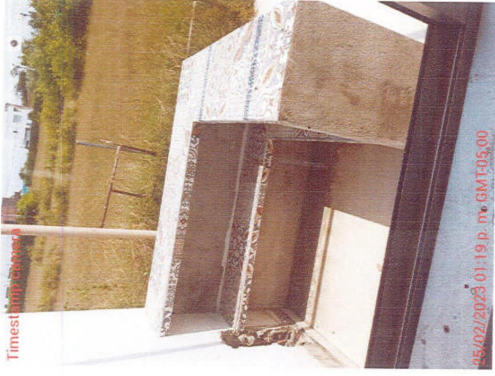
En la parte exterior de la cocina se construyó un mesón en concreto con un entrepaño, el cual cuenta con enchape por la parte superior del mesón y el entrepaño, pero las paredes están pañetadas en obra gris.
