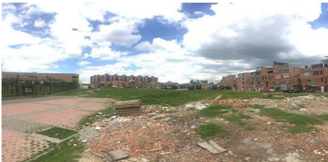
Fotografía 4A. ETAPA IV. CTA zona comunal. Septiembre 2020
