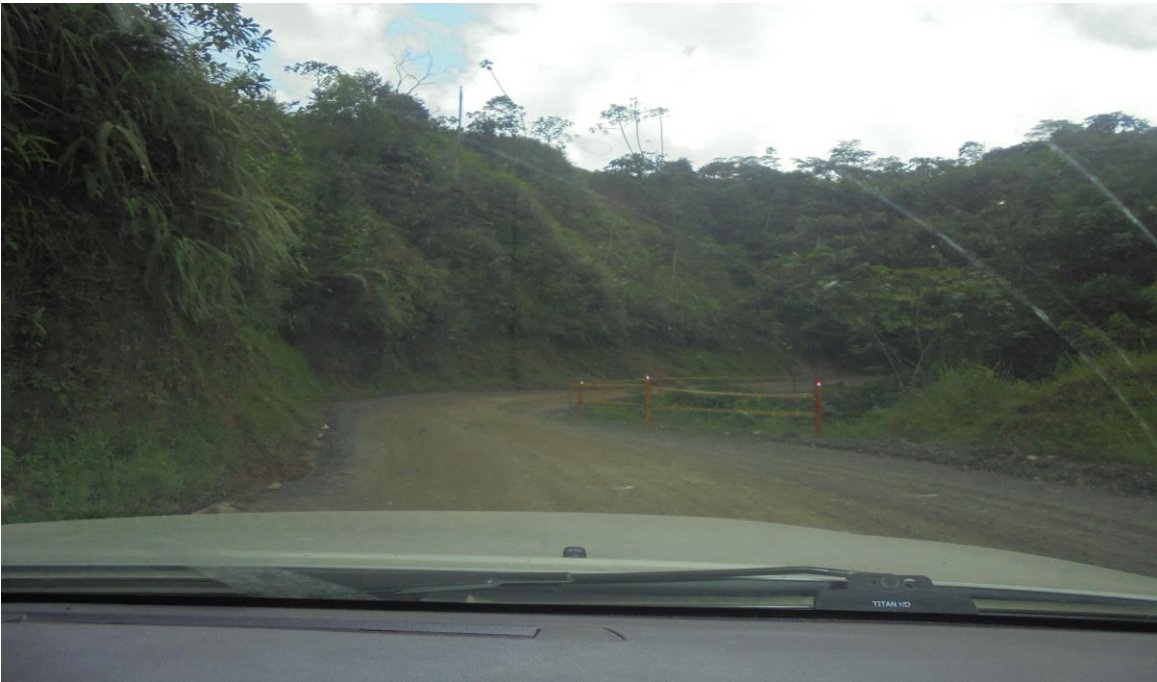
Señalización balizas tubulares 65+520
