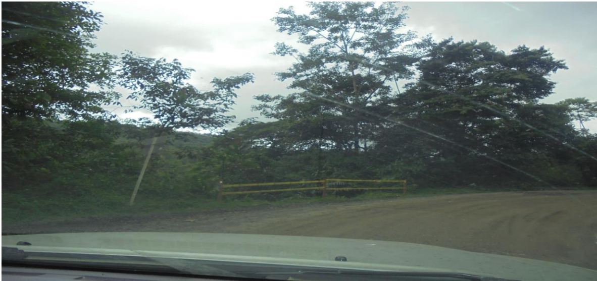
Señalización Balizas Tubulares 65+900
