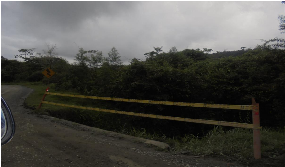
Señalización balizas tubulares 65+240
