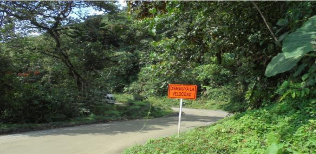
Foto: Señal tomada 200mt antes del sitio del accidente – (km 65+900 Aproximadamente)
