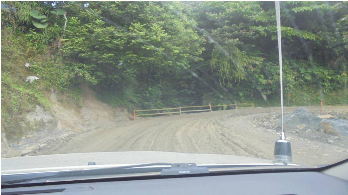
Señalización Balizas Tubulares 65+600
