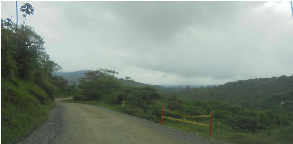
Señalización Balizas tubulares 65+150
