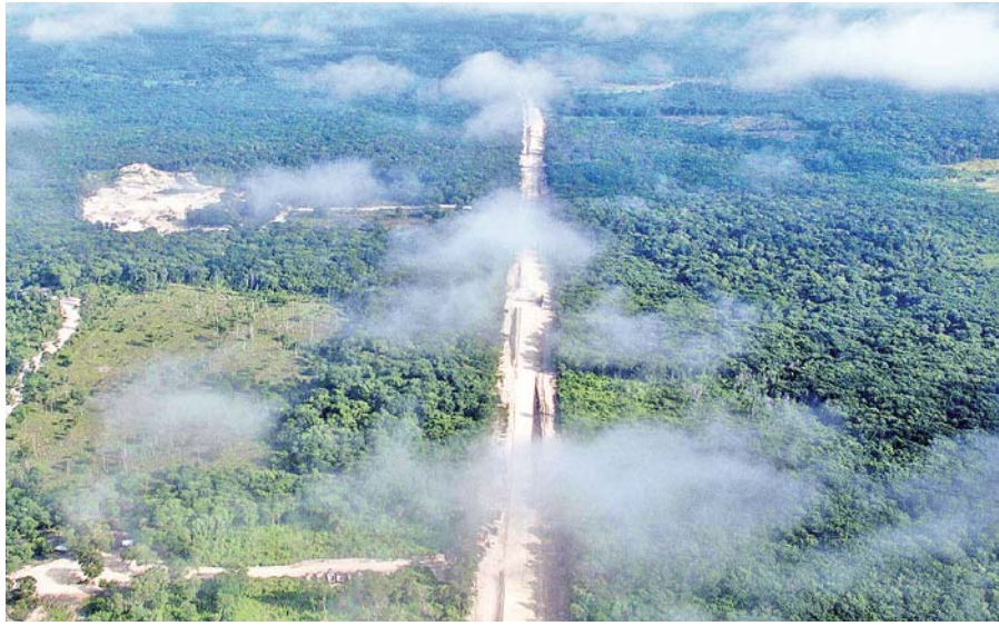
VISTA A aérea de la construcción del Tren Maya en Escarcega, en el estado mexicano de Campeche. /Foto AFP -Pedro Pardo
