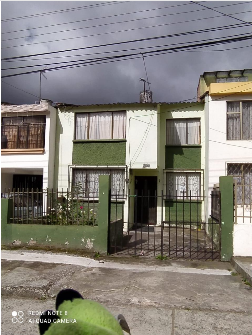
VISTA GENERAL DEL FRENTE DEL INMUEBLE A JUNIO 3 DE 2021
