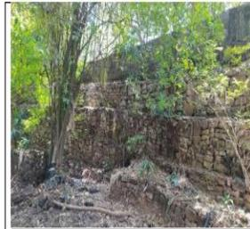
Imagen 1: Muro de contención zanja "el coyal"
