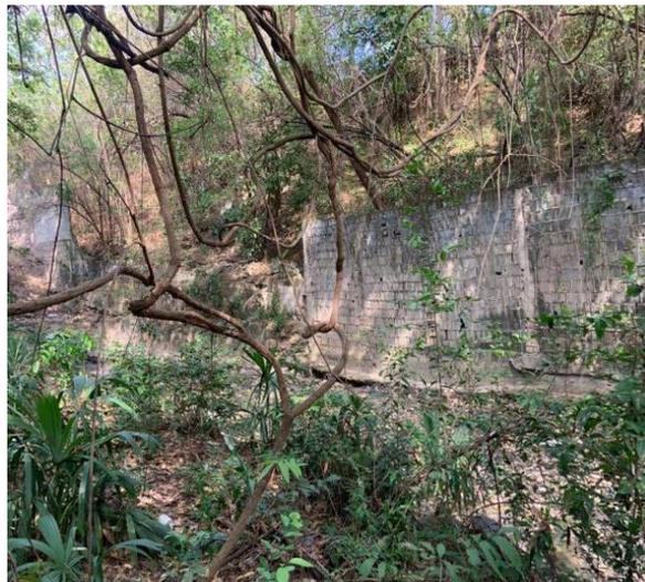
2. Actualmente **el muro, presenta en toda su longitud, desplome vertical, con una diferencia entre la parte superior e inferior de hasta 10cm; situación que claramente representa un riesgo de colapso, al existir un desplazamiento entre el eje de carga y el eje de apoyo del muro.**
