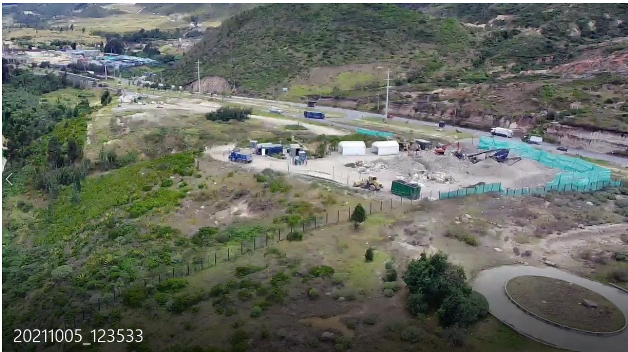
Fuente: Comité de Verificación, imagen tomada con vuelo de drone del 05 de octubre de 2021
