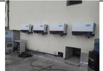
Ilustración No.07: instalación de 4 Inversores en la terraza del 4 piso en el Palacio de Justicia Rodrigo Lara Bonilla de Neiva.
