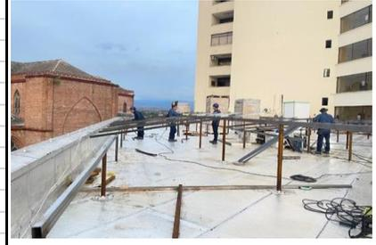
Ilustración No.03: Proceso constructivo de la instalación de 268 Paneles solares en la terraza del 4 piso en el Palacio de Justicia Rodrigo Lara Bonilla de Neiva.
