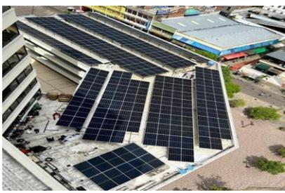
Ilustración No.01: 268 Paneles solares instalados en la terraza del 4 piso en el Palacio de Justicia Rodrigo Lara Bonilla de Neiva.
