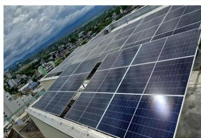
Ilustración No.04: 40 Paneles solares instalados en la terraza del 11 piso en el Palacio de Justicia Rodrigo Lara Bonilla de Neiva.
