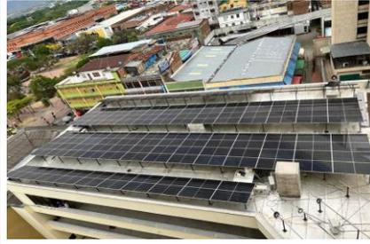
Ilustración No.02: Proceso constructivo de la instalación de 268 Paneles solares en la terraza del 4 piso en el Palacio de Justicia Rodrigo Lara Bonilla de Neiva.
