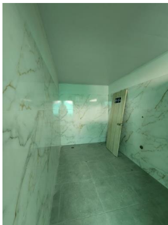
ADECUACION INTEGRAL BATERIAS DE BAÑOS DEL EDIFICIO
