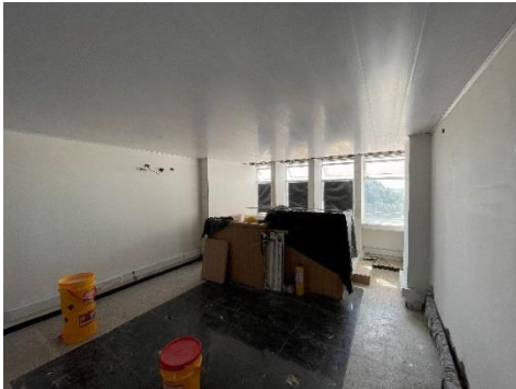
INTERVENCION SISTEMA DE CIELO RAZO – REEMPLAZO DE DRYWAL POR PVC
