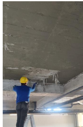
REFORZAMIENTO ESTRUCTURAL EN FOSO DE ASCENSOR PARA EQUIPO NUEVO
