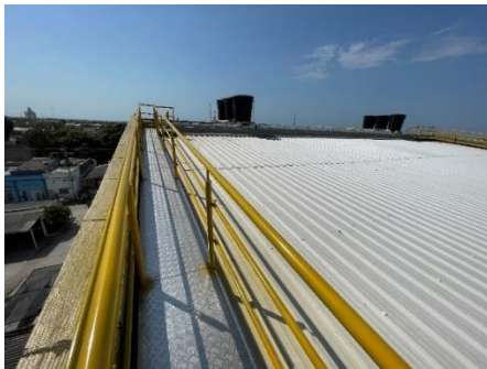
PROCESO DE REEMPLAZO DE CUBIERTA POR LAMINAS EN PVC TIPO TERMO ACUSTICAS, ESTRUCTURA Y PERFLERIA DE SOPORTE METALICA
