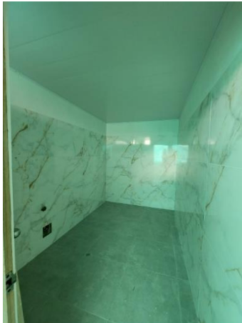
INTERVENCION SISTEMA DE CIELO RAZO – REEMPLAZO DE DRYWAL POR PVC
