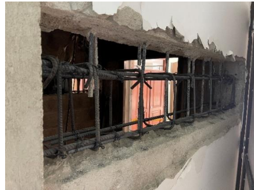
REFORZAMIENTO ESTRUCTURAL EN FOSO DE ASCENSOR PARA EQUIPO NUEVO
