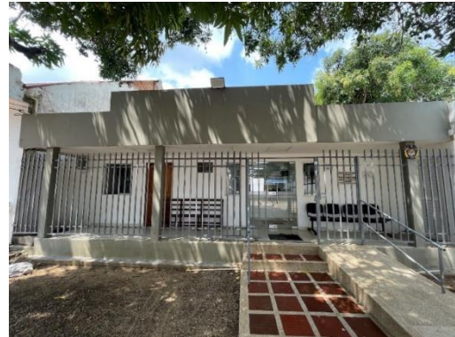
VISTA GENERAL FACHADA SEDE SAN SEBASTIAN
