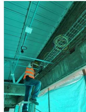
ADECUACION RED ELECTRICA 4° PISO – INSTALACION DE ACOMETIDAS, TABLEROS Y PUNTOS ELECTRICOS.
