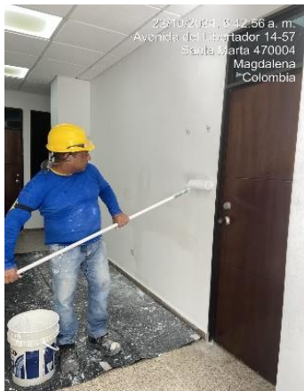
INTERVENCION EDF. INFANCIA Y ADOLESCENCIA. MANTENIMIENTO DE PINTURA DE FACHADA E IMPERMEABILIZACION
