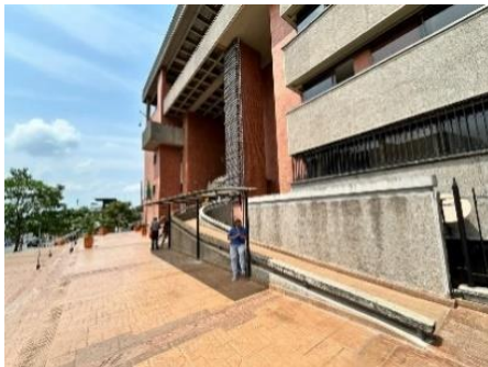
Gráfico 20. Rampa de acceso para personas con movilidad reducida
