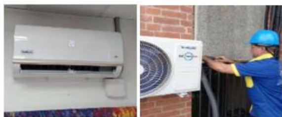
Figura 14. Instalación de aires acondicionados
