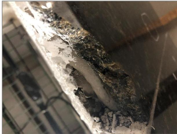
*Foto 1. Estado de las piedras de revestimiento de granito en acceso a ascensor. Edificio Centro Cívico.*
