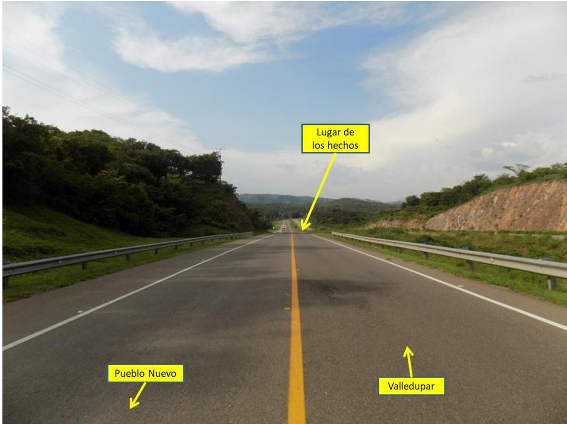
**FOTOGRAFÍA No. 2 PANORÁMICA:** En esta fotografía tomada por el equipo de IRS Vial en sentido Pueblo Nuevo – Valledupar a la altura del km 39 + 300 m, se aprecian las características generales de la vía, en la cual se encuentra demarcación horizontal de línea amarilla continua y líneas de borde, sin señalización vertical; en este sentido se desplazaba el vehículo No. 1 (Camioneta).
