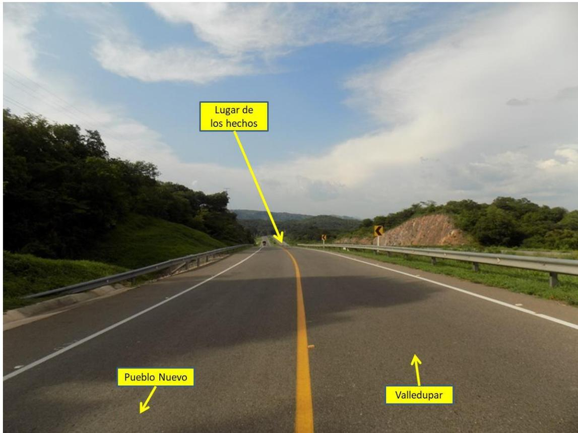
**FOTOGRAFÍA No. 4 PANORÁMICA:** En esta fotografía tomada por el equipo de IRS Vial en sentido Pueblo Nuevo – Valledupar a la altura del km 39 + 300 m, se aprecian las características generales de la vía, en la cual se encuentra demarcación horizontal de línea amarilla continua y líneas de borde, con señalización vertical delineadores de curva; en este sentido se desplazaba el vehículo No. 1 (Camioneta).
