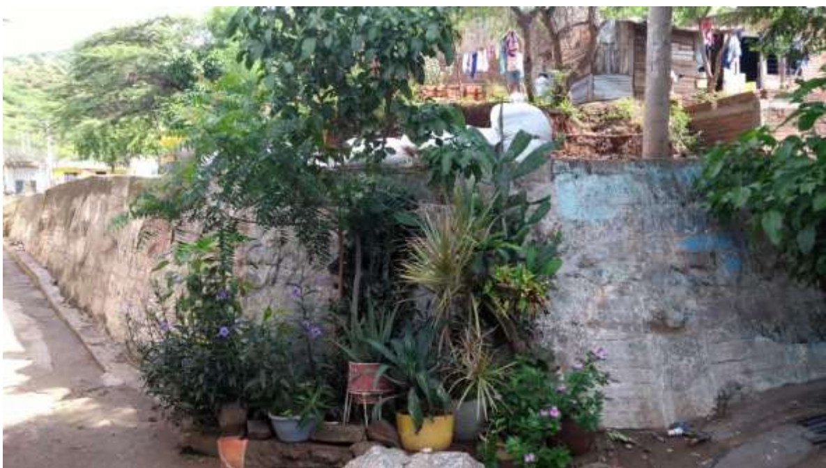
IMAGEN 7: Muralla divisoria y protectora entre las viviendas y la carretera en forma de pendiente.
