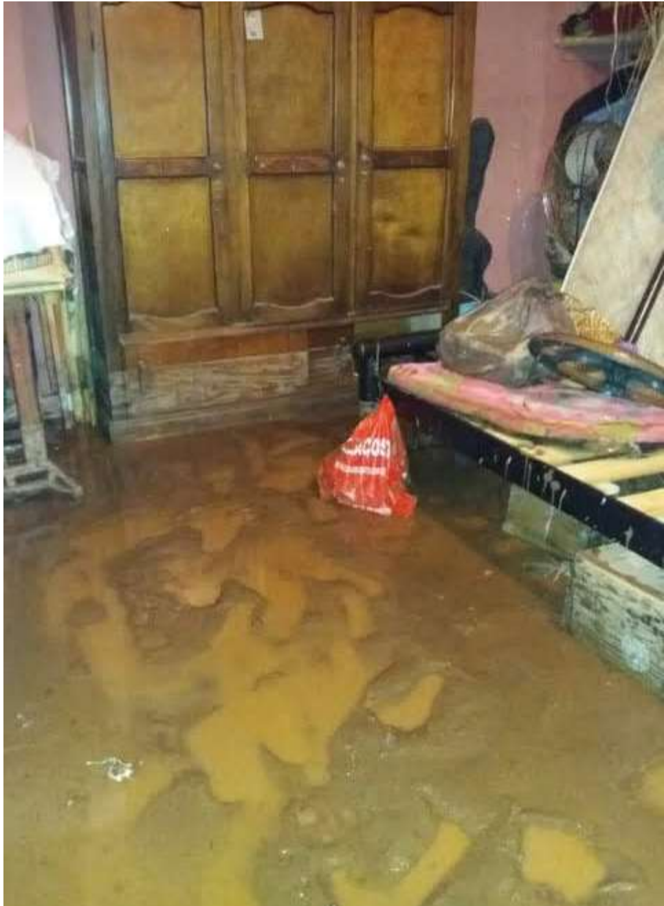
IMAGEN 9: Afectación a las alcobas de una de las viviendas afectadas por el desbordamiento de la muralla.
