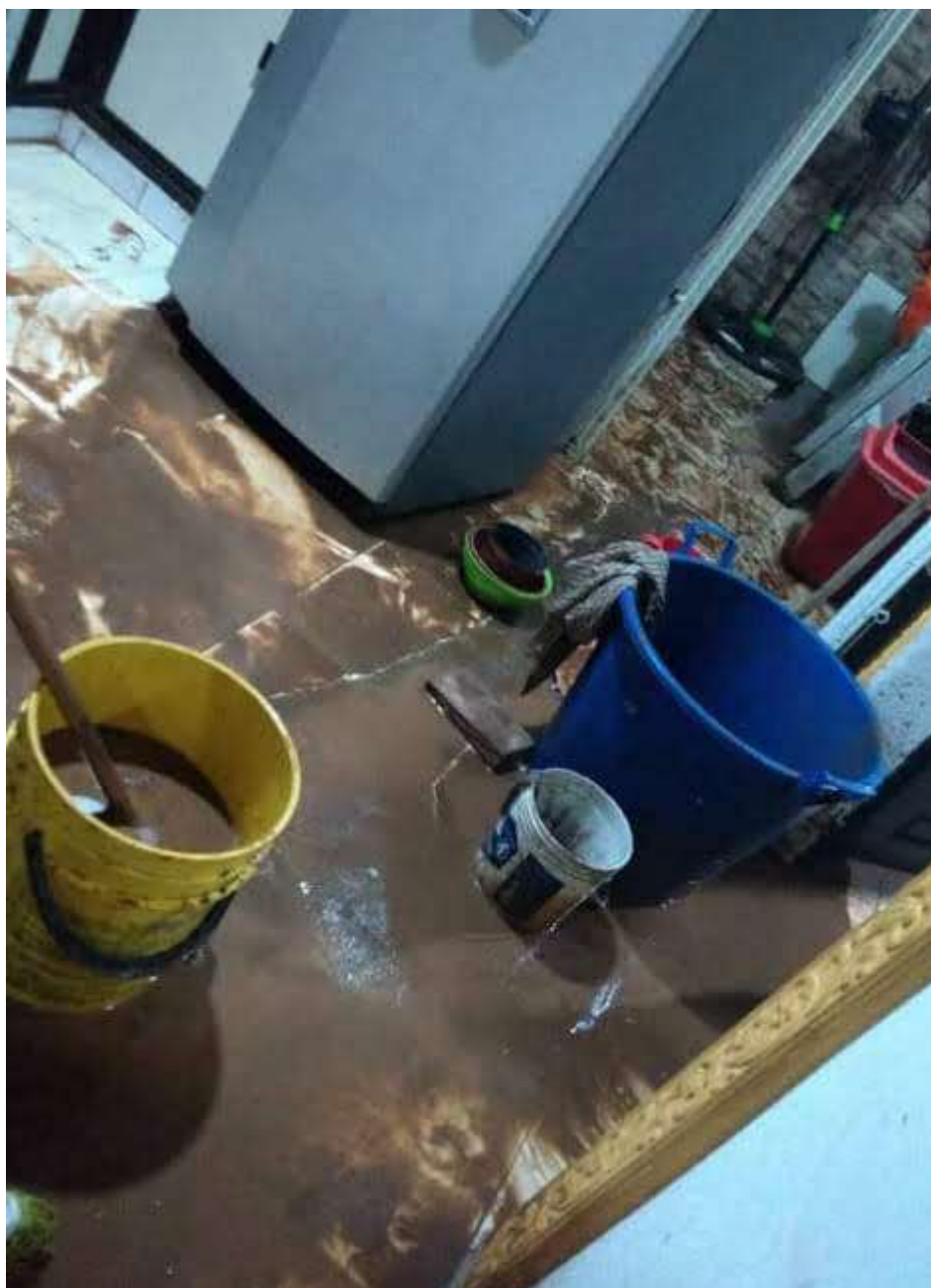
IMAGEN 16: Vivienda afectada por el traspaso del sedimento a la muralla.
