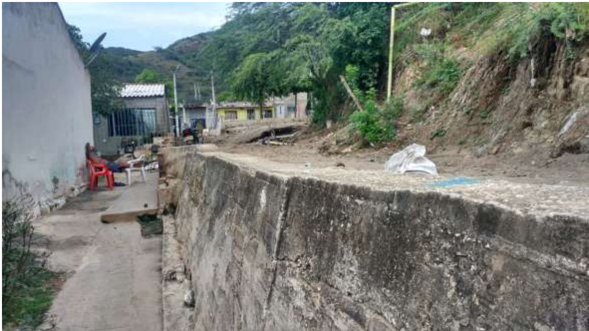
IMAGEN 3: Muralla que divide las viviendas con la pendiente.
