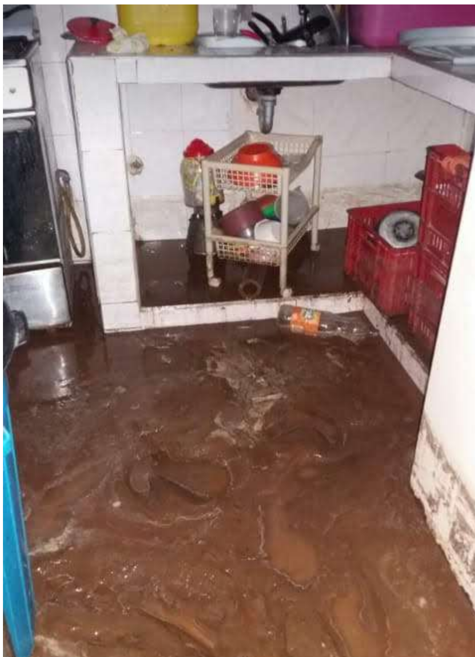
IMAGEN 8: Cocina de una de las viviendas afectadas por el desbordamiento del sedimento a la muralla.
