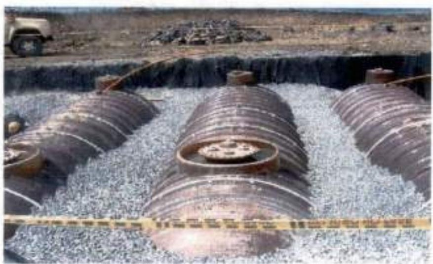
**Anclaje de Tanques de almacenamiento de combustibles conforme a la norma**
